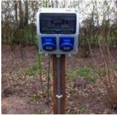
Voorbeeld stroom aansluit punt.
