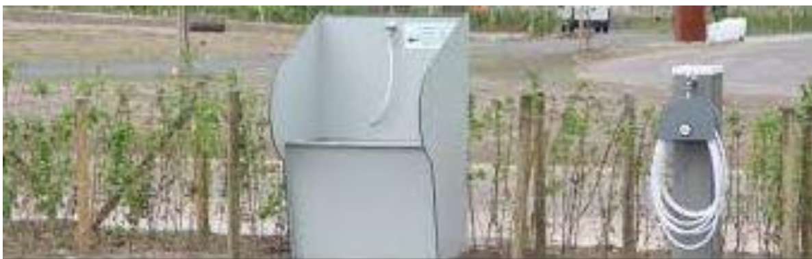
Een met Trespa afgewerkte toilet uitstort met spoelwater, en spoelwater zuil.
