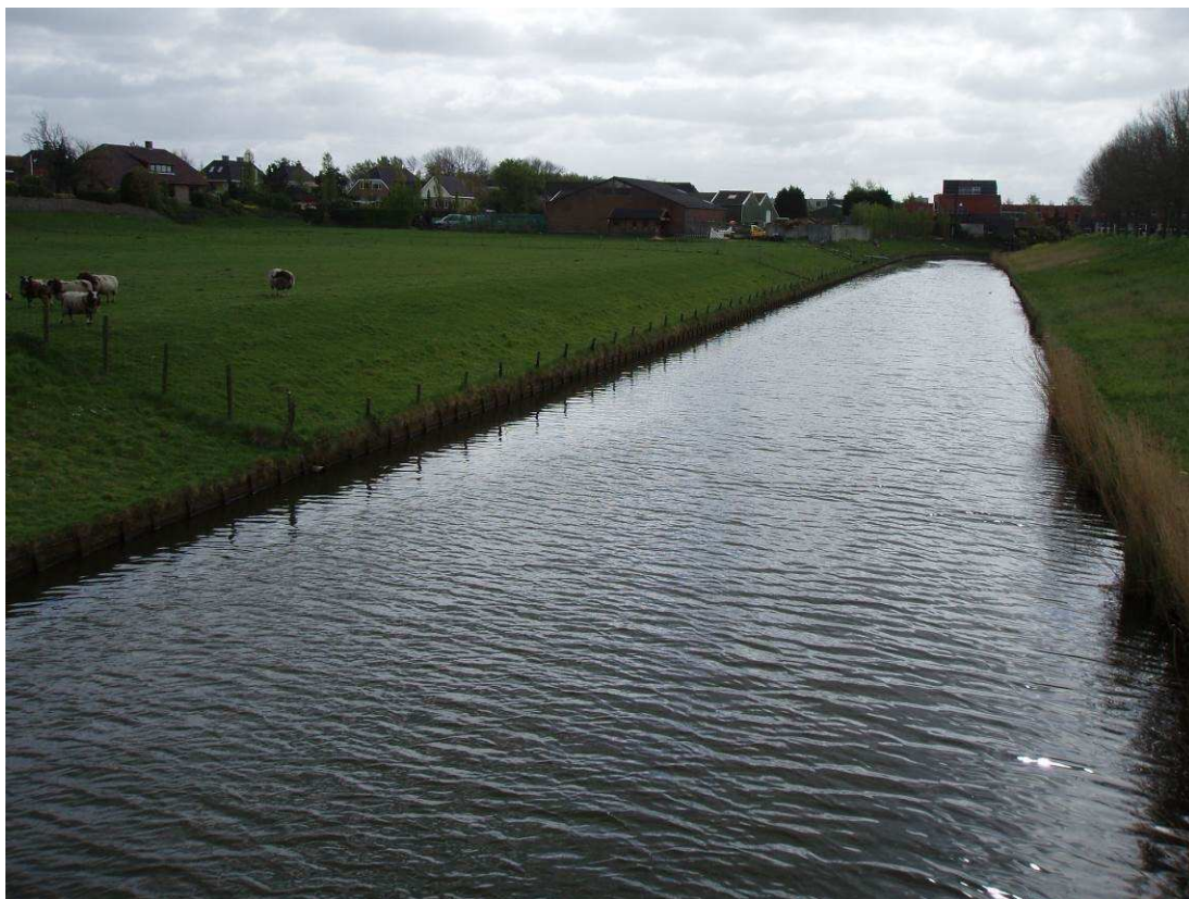
Beschoeiing die wordt verhoogd ivm verplaatsen van de stuw
