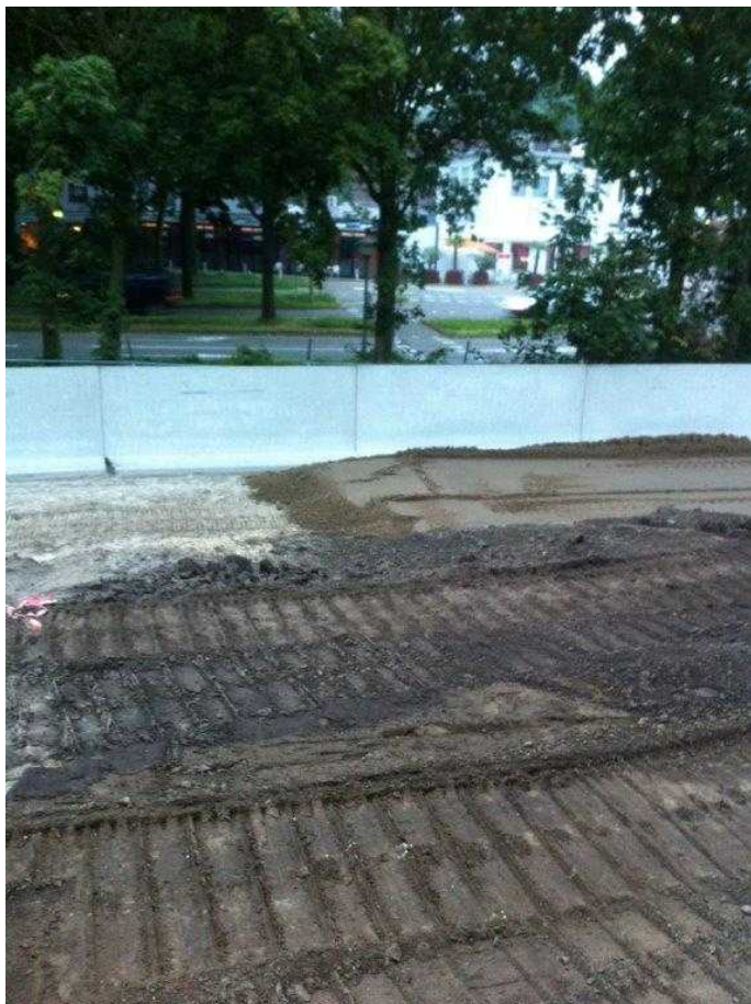
Foto 5: Plaatsen verontreinigde grond op de keerwand (maximaal tot 1,0 m onder niveau toekomstig maaiveld)
