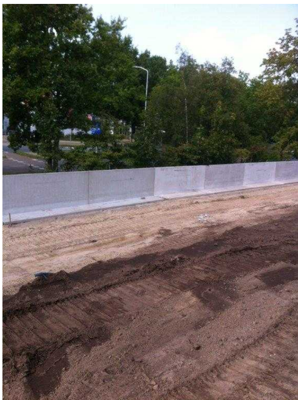
Foto 4: Plaatsen van de keerwand
