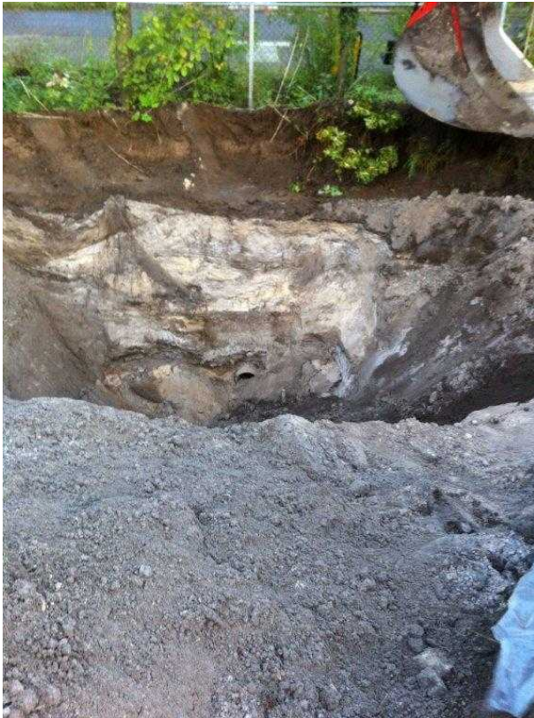
Foto 1: Verwijderen riolering, ter hoogte van plaats waar riool is afgeschuimd
