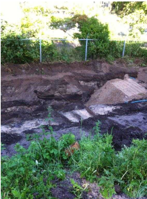
Foto 2: Aanvullen van sleuf
