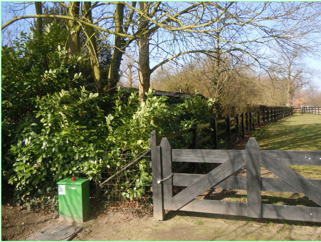
foto 4 _ achterzijde vanaf Domineespaadje
