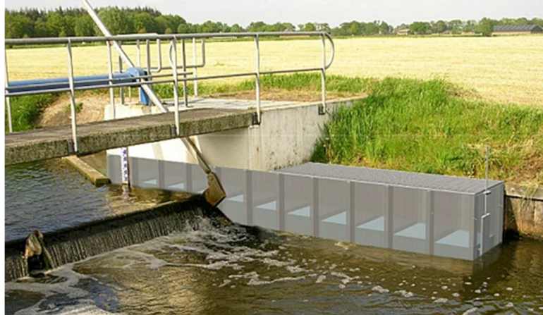
De Witvispassage geplaatst bij een bestaande stuw.
