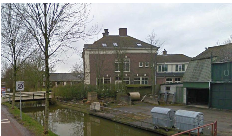
Afb. 6 Herenhuis ten westen van het voormalige bedrijf
