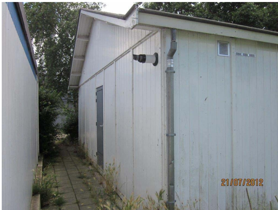
Foto: Looppad aan de oostzijde, 1.20m breed tussen de container en het bestaande pand
