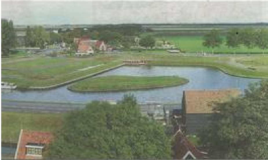
Figuur 2.2: Foto huidige situatie
