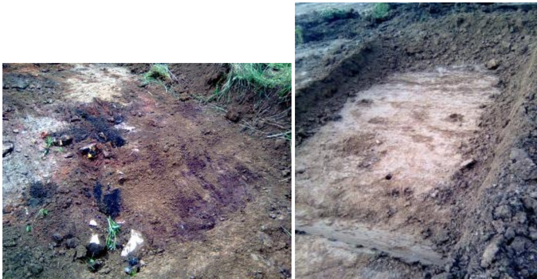
Figuur 2 Links ontgraving zwerfpyriet / Rechts putbodem bij controlemonster B002
