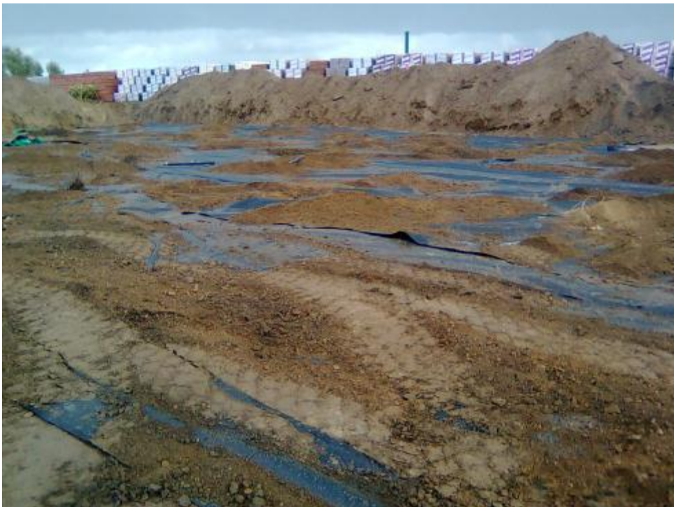
Foto 6: aanbrengen folie vak V
