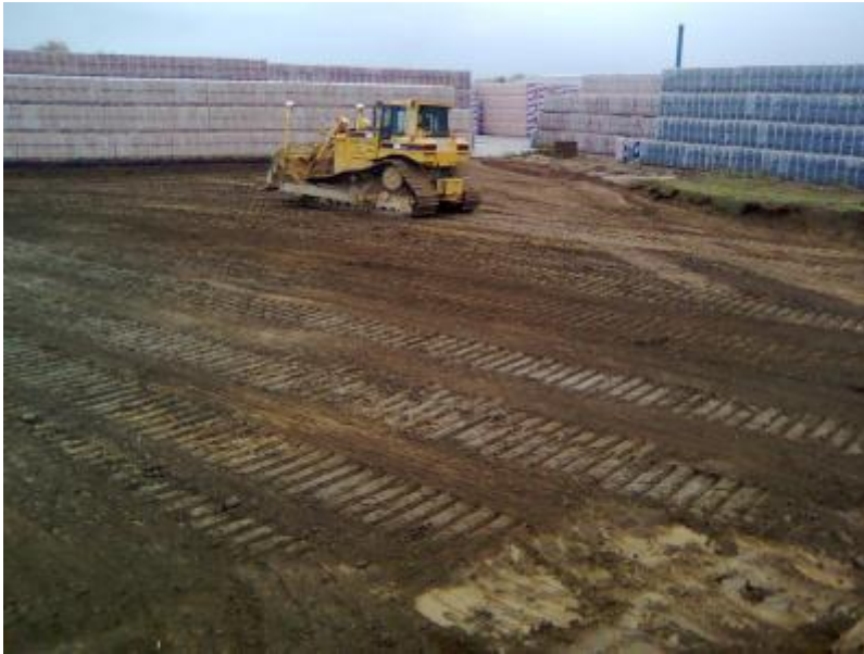
Figuur 6 Profileren schone zandlaag
