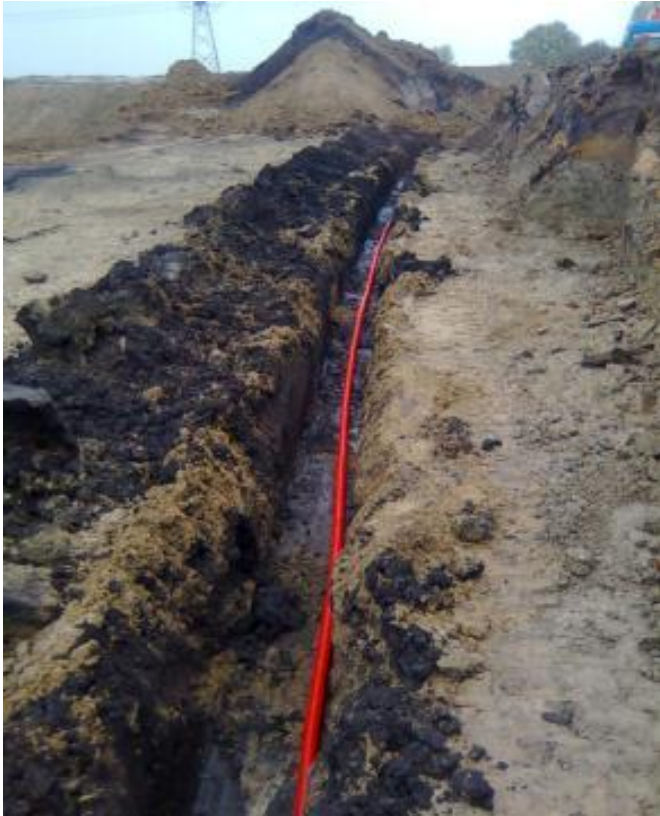
Figuur 5 aanleg mantelbuis
