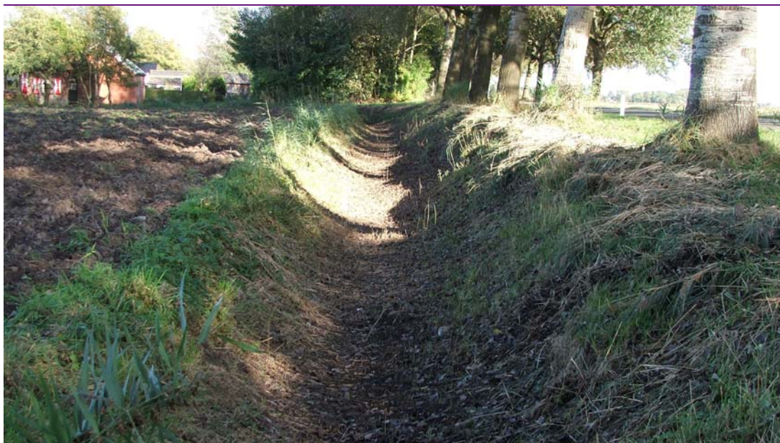
Figuur 3.3 Droogstaande watergang direct ten noorden van de N363 ter hoogte van Wadwerd
