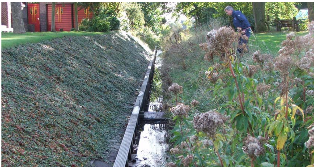
Figuur 3.1 Krap gedimensioneerde hoofdwatrgang tussen Wadwerderweg 11 en 13 bij de stuw
