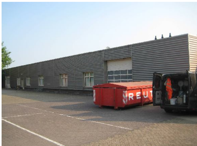
Figuur 7 : Bestaand opslagmagazijn op de planlocatie
