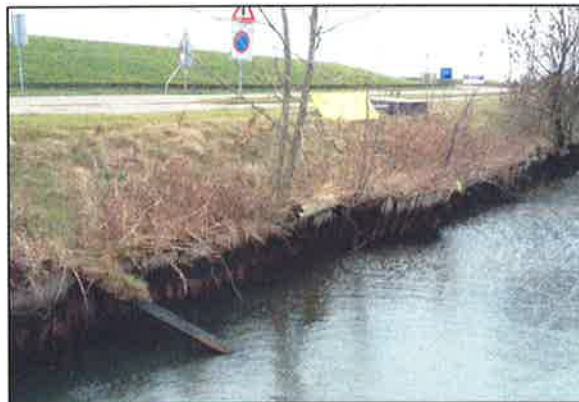
Figuur 2. Damwand langs IJsselmeerdijk
