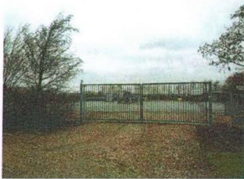
Bestaande NAM locatie Reedijk.
