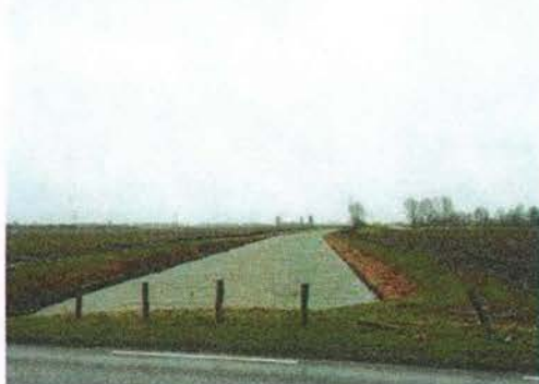
Watergang 'De Vliet' ter hoogte van de Provincialeweg in Heinenoord.
