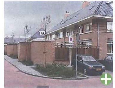
Goed geplaatst bijgebouw in bijgebouw passende vormgeving, materialen en kleuren
