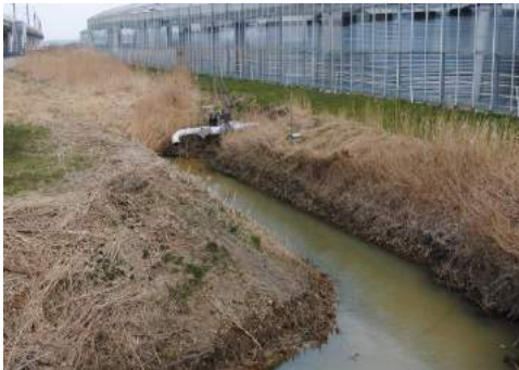
2. Derde Tocht t.p.v. duiker onder HSL-viaduct (1)
