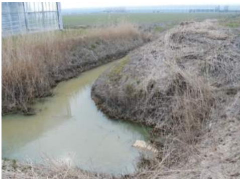
3. Derde Tocht t.p.v. duiker onder HSL-viaduct (2)
