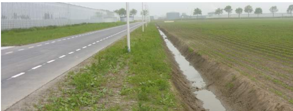
12. Overzicht situatie greppel langs noordzijde Cyclamenweg ten westen van HSL-viaduct
