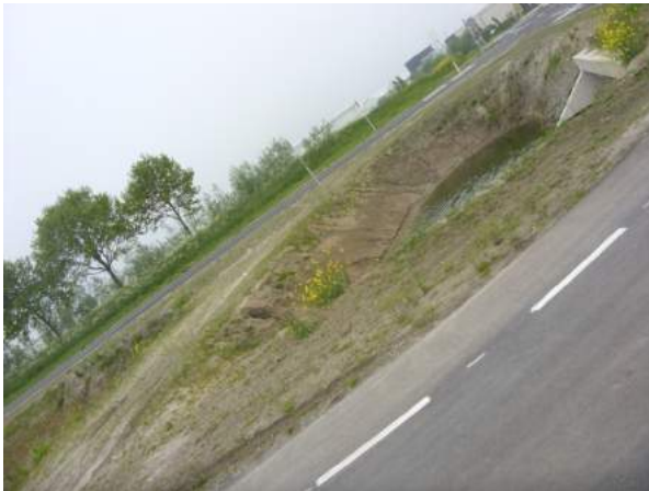
14. Situatie tijdelijke dam en definitieve duiker bij aansluiting Cyclamenweg op ZoRo-busbaan
