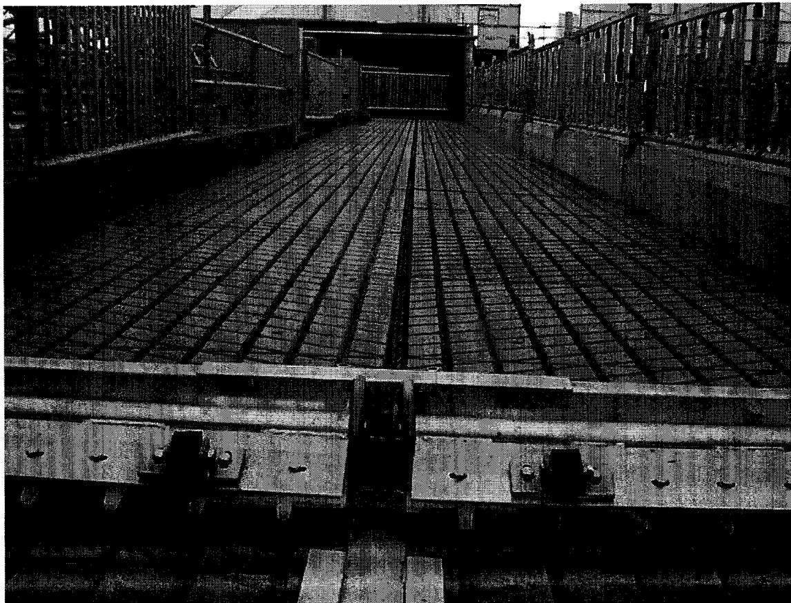
Sleufdetail vloervariant C:
