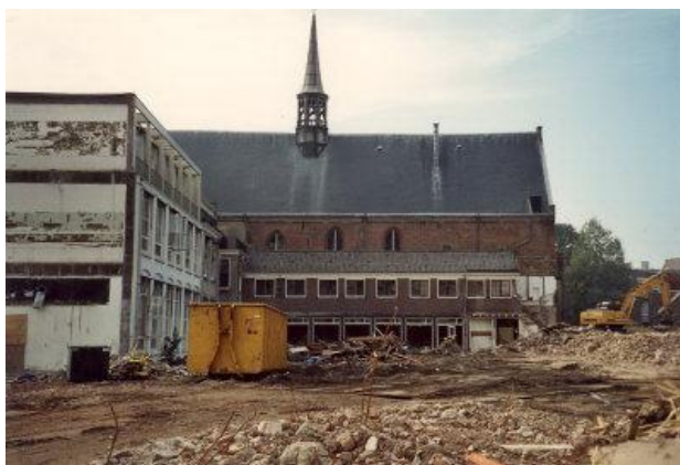
Voorbereiding sanering Janskliniek
