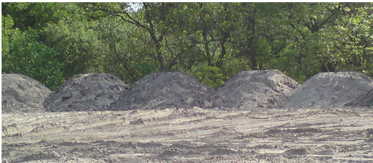
Tijdelijk gronddepot Reinaldapark
