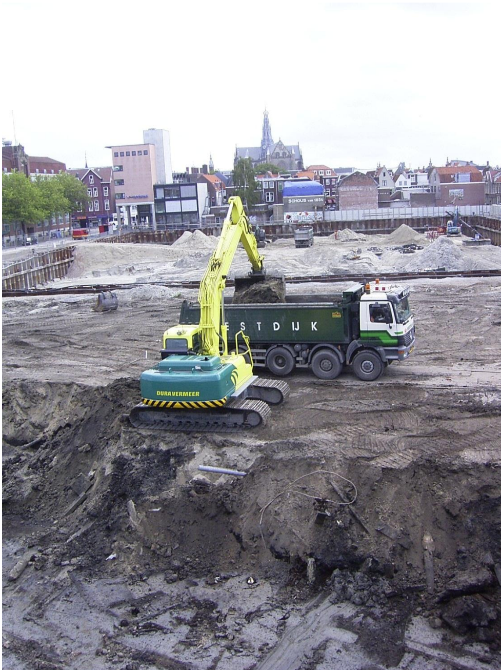
Raaks, afgraven gasfabrieksgrond
