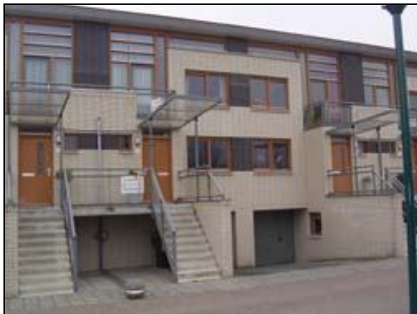
Figuur 3.9 Woningen met souterrains aan de H.P. Berlagelaan te Oegstgeest.
