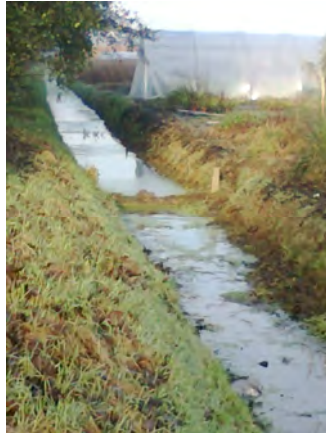
Figuur Fout! Geen tekst met opgegeven opmaakprofiel in document.-2: Stuw 36 (ID 415-056-00036) waar het water omheen loopt, in waterloopvak 00025
