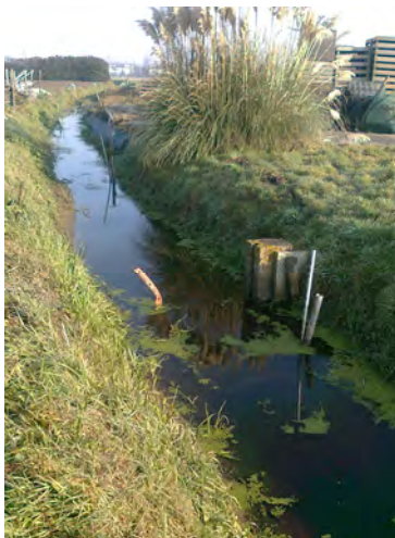
Figuur Fout! Geen tekst met opgeven opmaakprofiel in document. -1: Stuw 37 (ID 415-056-00037) die niet meer functioneert
