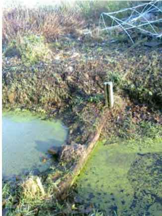
Figuur Fout! Geen tekst met opgegeven opmaakprofiel in document.-2: Stuw 36 (ID 415-056-00036) waar het water omheen loopt, in waterloopvak 00025
