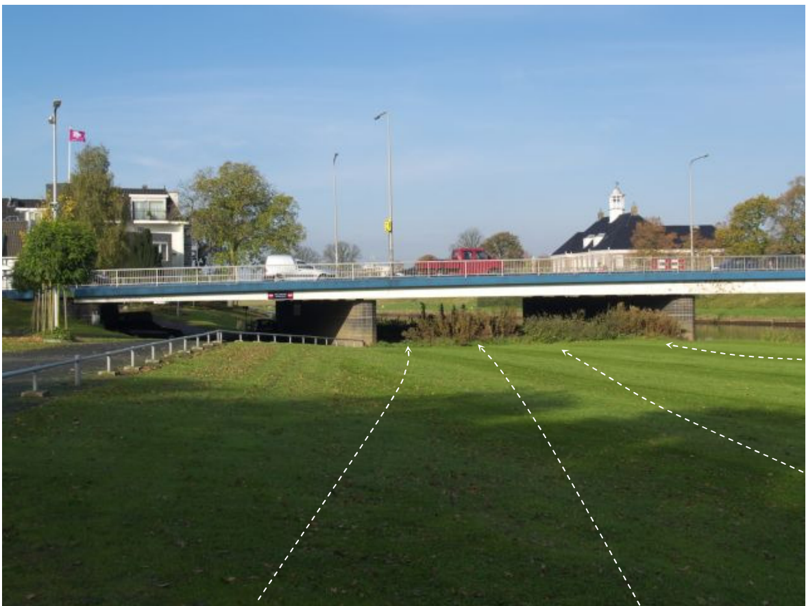
Figuur 2-5 Teruglopende uiterwaardbreedte en obstakels voor de brug, bovenstroomse zijde brug
