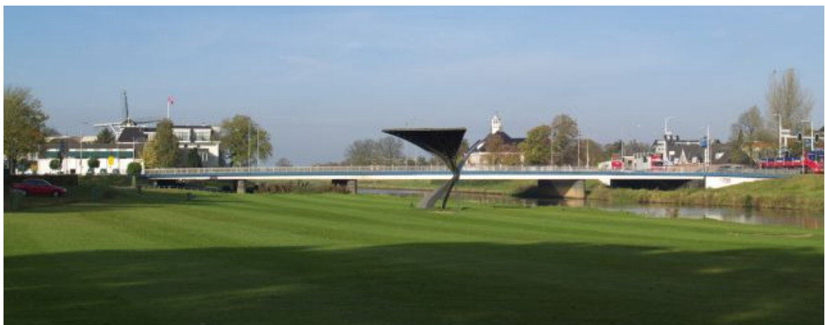
Figuur A-2 Hesselmulertbrug gezien vanaf de bovenstroomse zijde
