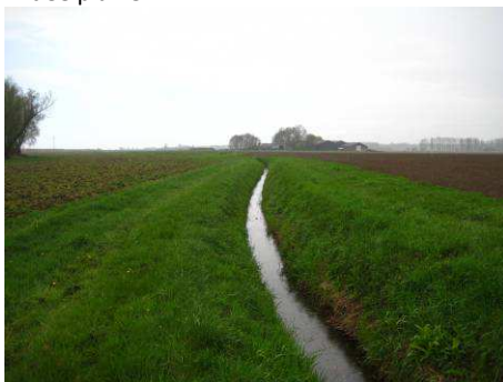
Te dempen/verondiepen greppel in deelplan 4
