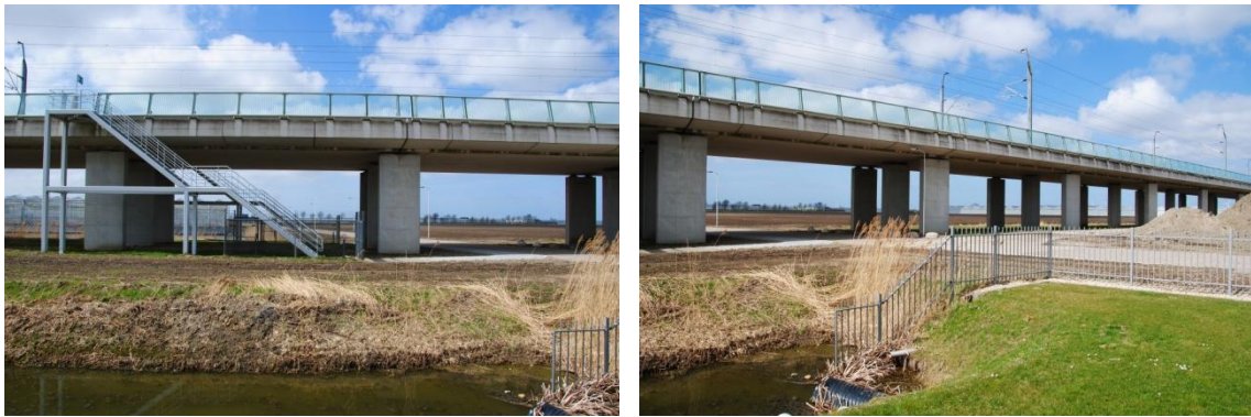
Figuur 3.3: zicht vanaf het trafohuisje op de HSL-lijn.
