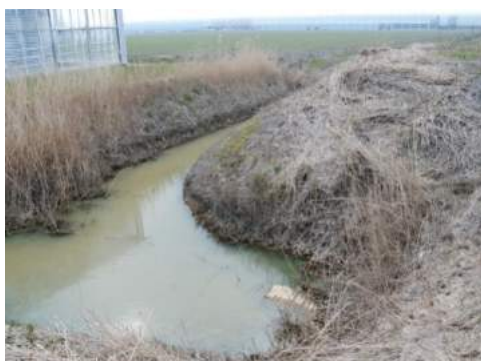
3. Derde Tocht t.p.v. duiker onder HSL-viaduct (2)
