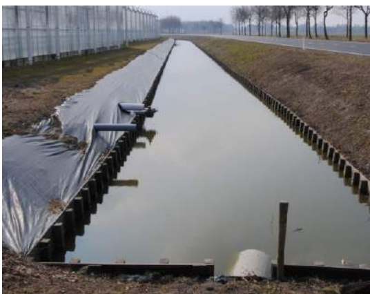
8. Overzicht vanaf duiker (onder afschot) naast ZoRo-busbaan (2)
