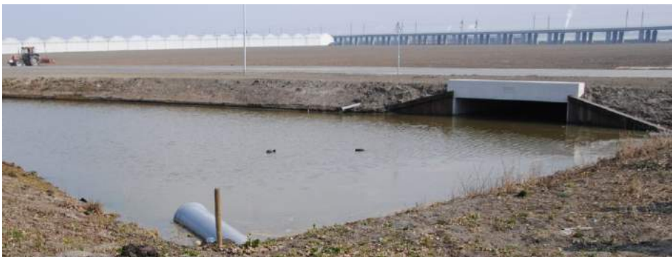
7. Overzicht vanaf duiker (onder afschot) naast ZoRo-busbaan (1)
