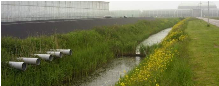
9. Overzicht watergang Petuniaweg met stuw en afwatering bassins glastuinbouw
