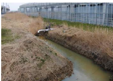
2. Derde Tocht t.p.v. duiker onder HSL-viaduct (1)
