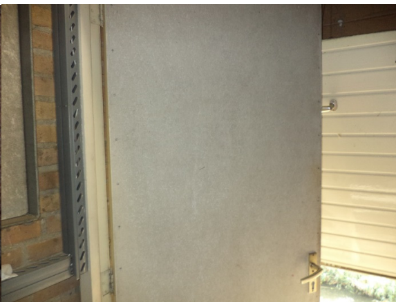
Foto 2. Zachte witte plaat cv-ruimte, Pastoor Willemsestraat 36 t/m 58
