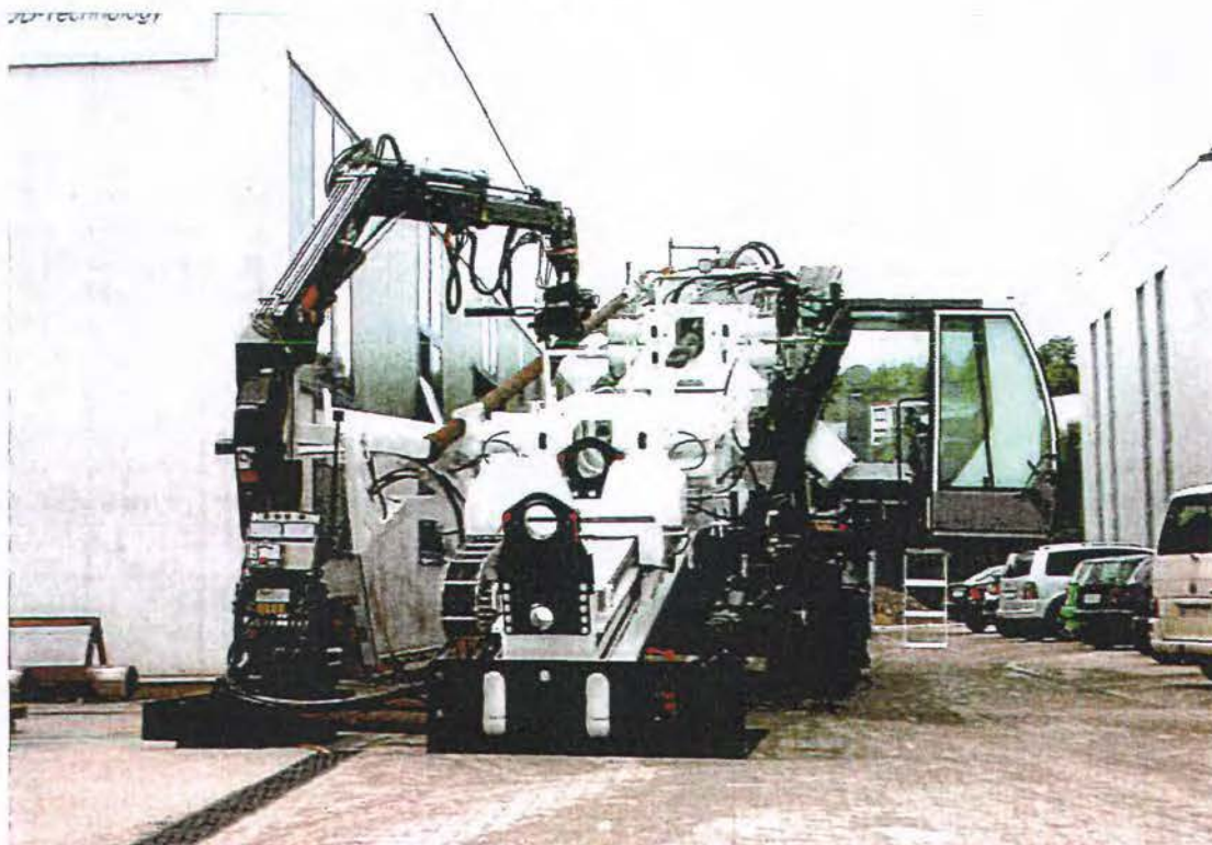
Afbeelding: 250 tons boor-rig Van Vulpen
