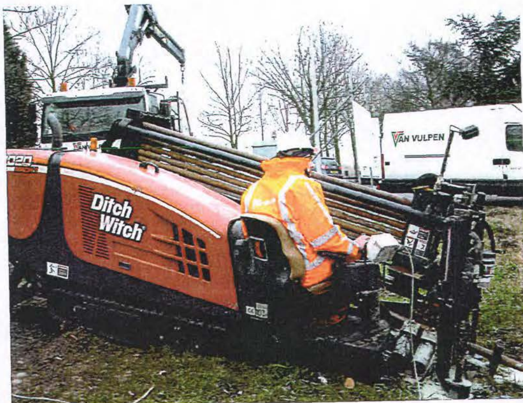
Afbeelding: 16 tons boor-rig Van Vulpen
