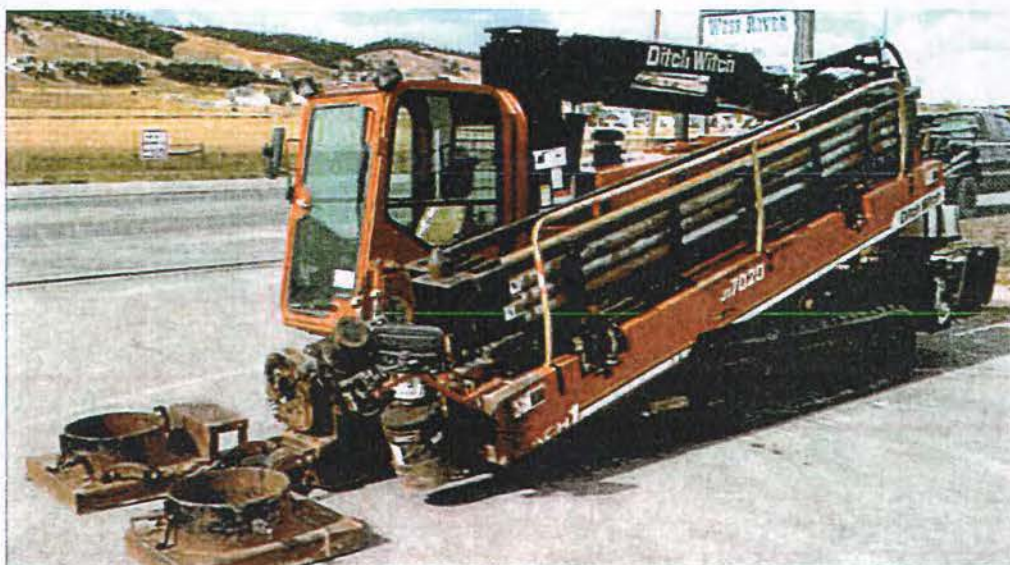
Afbeelding: 50 tons boor-rig Van Vulpen
