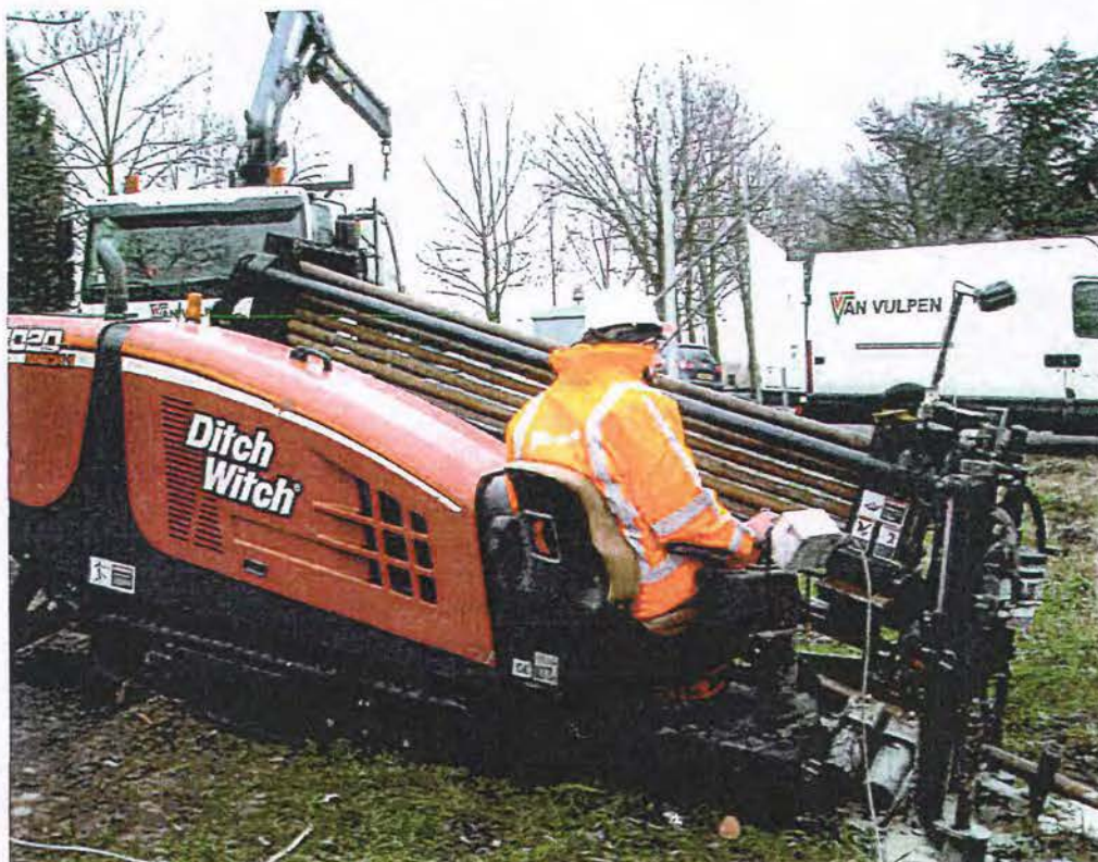
Afbeelding: 10 tons boor-rig Van Vulpen
