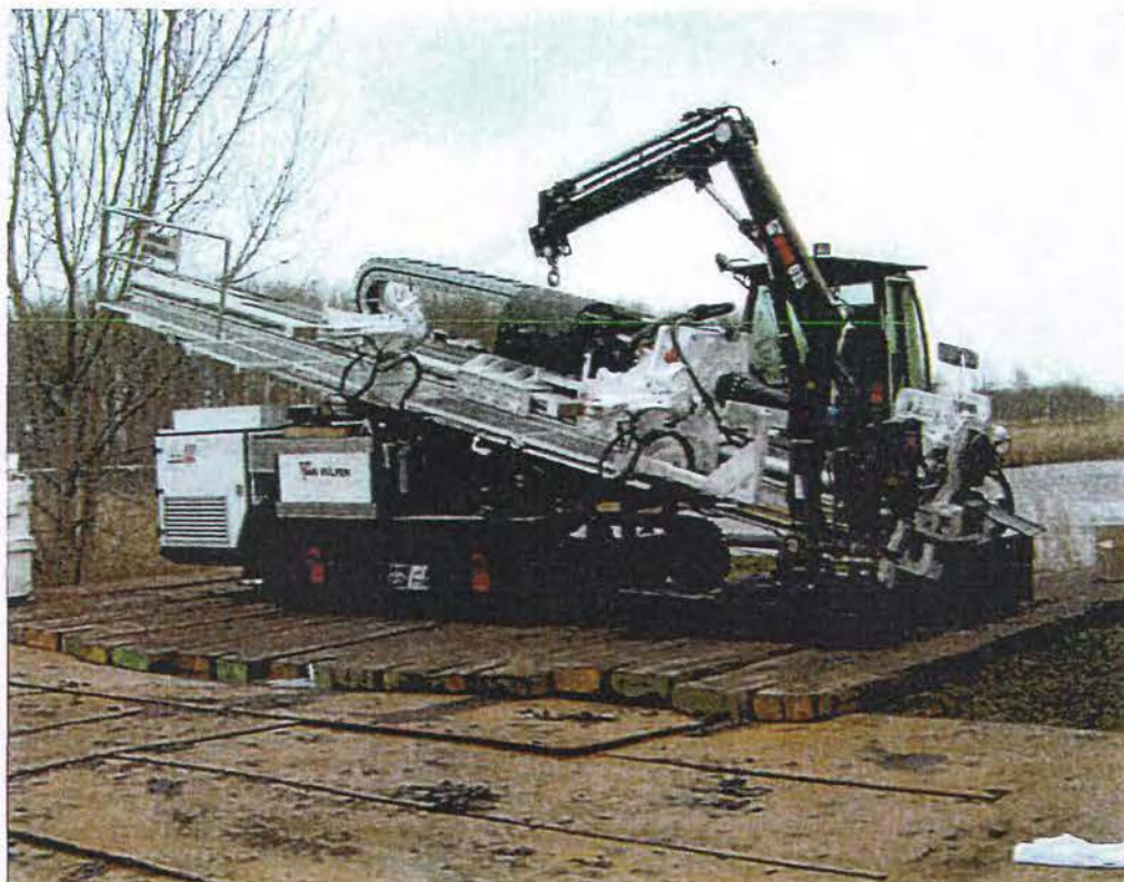
Afbeelding: 100 tons boor-rig Van Vulpen
