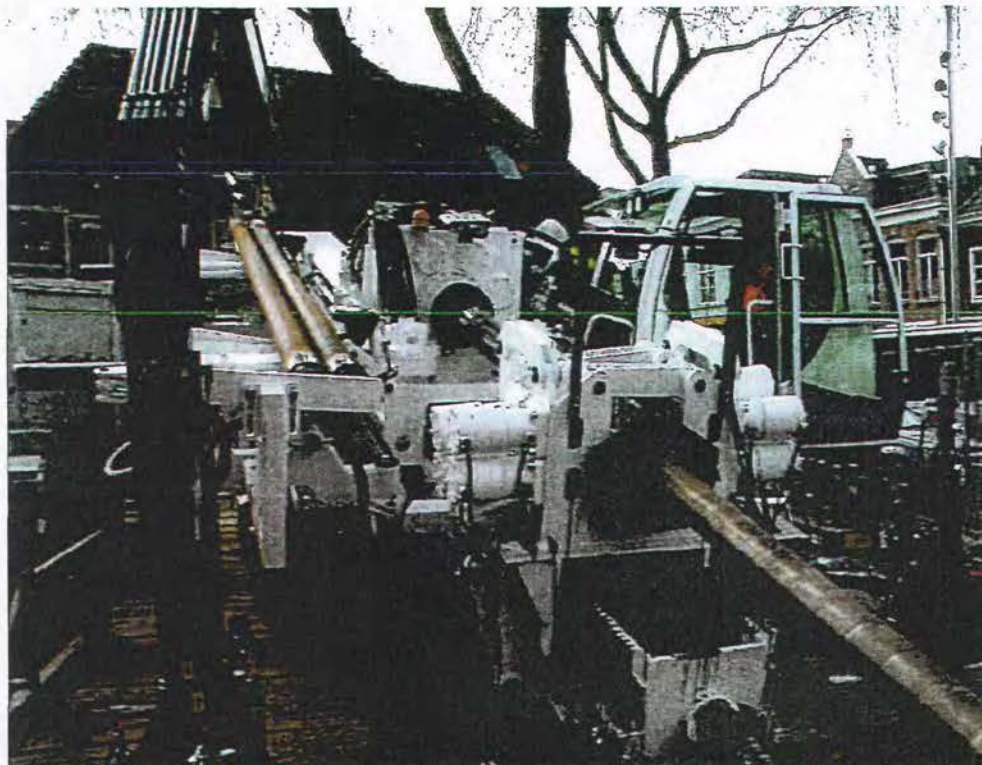
Afbeelding: 80 tons boor-rig Van Vulpen
