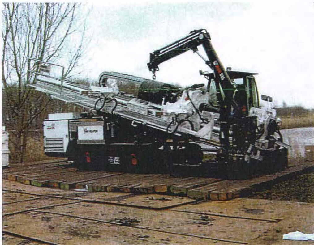
Afbeelding: 100 tons boor-rig Van Vulpen
