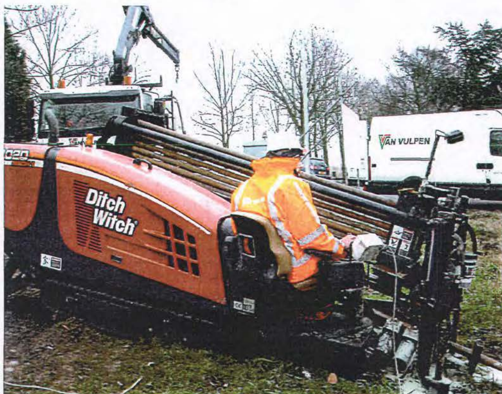
Afbeelding: 16 tons boor-rig Van Vulpen
