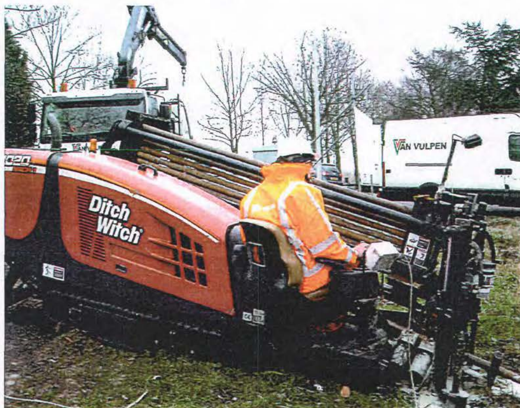
Afbeelding: 10 tons boor-rig Van Vulpen
