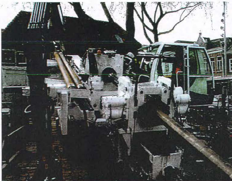
Afbeelding: 80 tons boor-rig Van Vulpen
