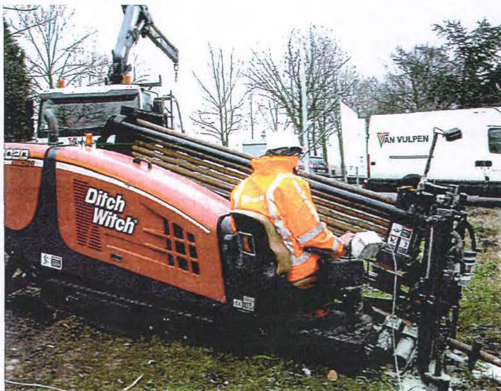
Afbeelding: 16 tons boor-rig Van Vulpen
