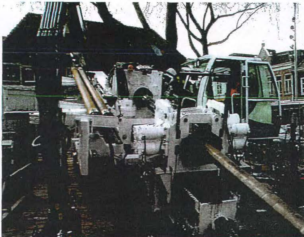
Afbeelding: 80 tons boor-rig Van Vulpen
