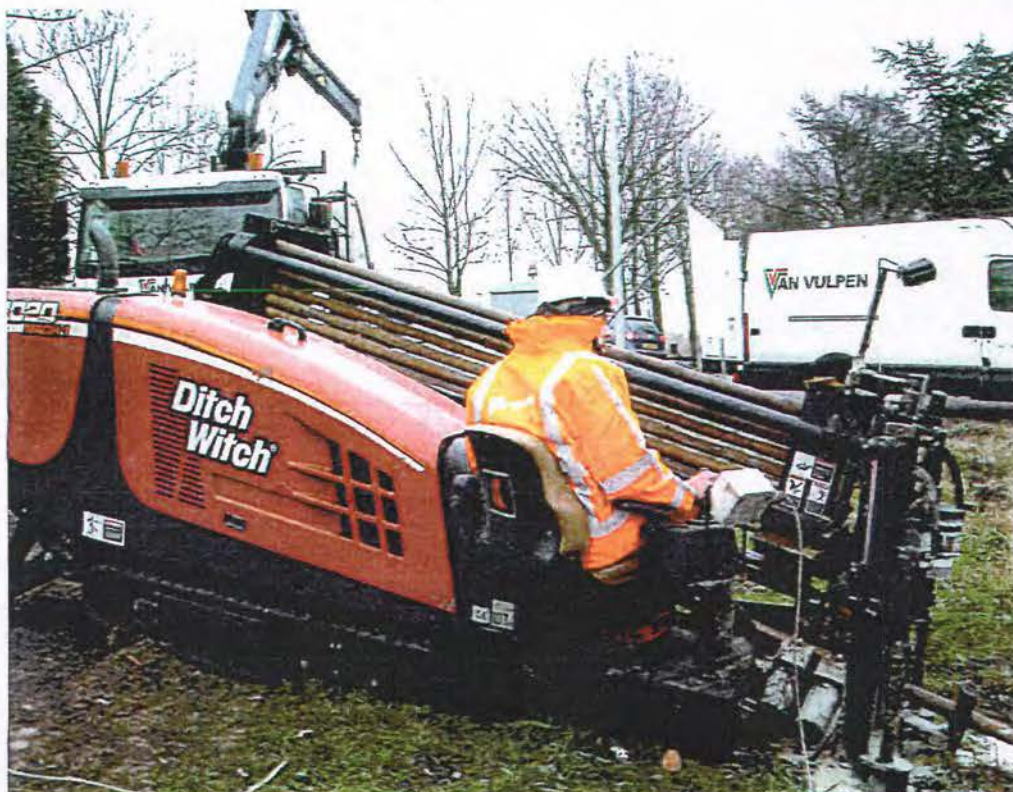
Afbeelding: 10 tons boor-rig Van Vulpen
