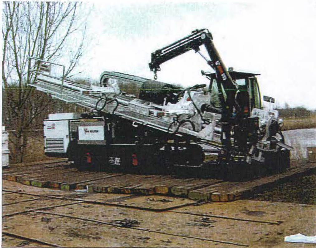
Afbeelding: 100 tons boor-rig Van Vulpen
