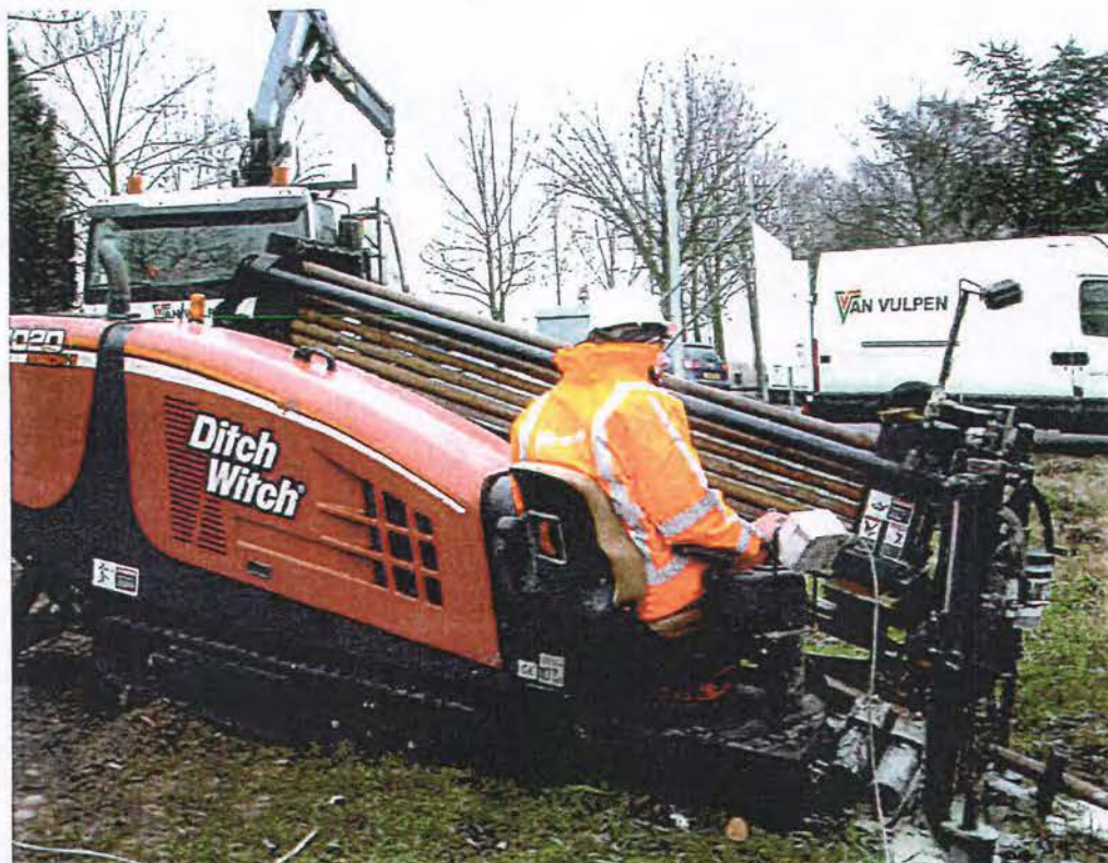
Afbeelding: 16 tons boor-rig Van Vulpen
