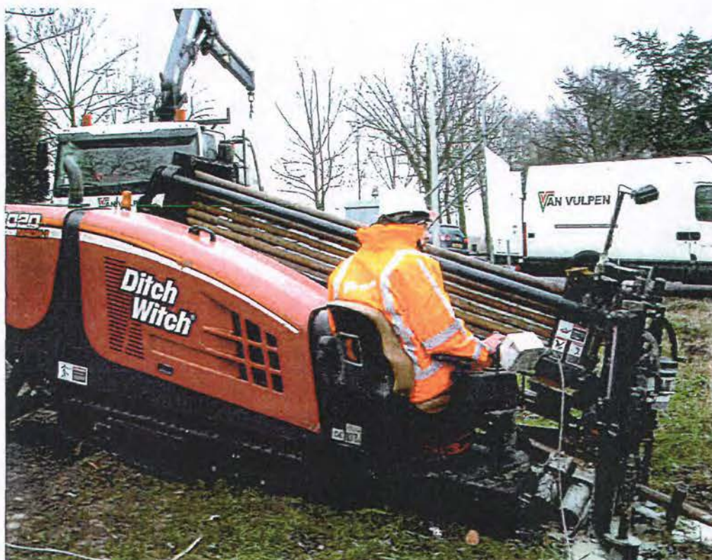
Afbeelding: 10 tons boor-rig Van Vulpem
