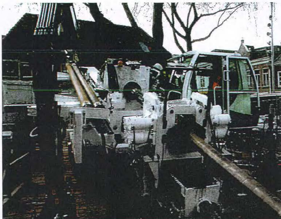
Afbeelding: 80 tons boor-rig Van Vulpen
