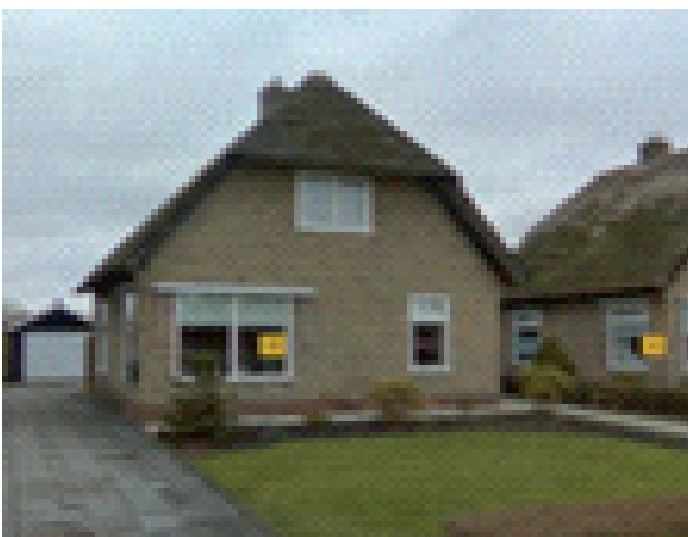
Zulthereschweg 10 zeldzaam voorbeeld van rietgedekte sociale woningbouw, Woonborg, 1950
