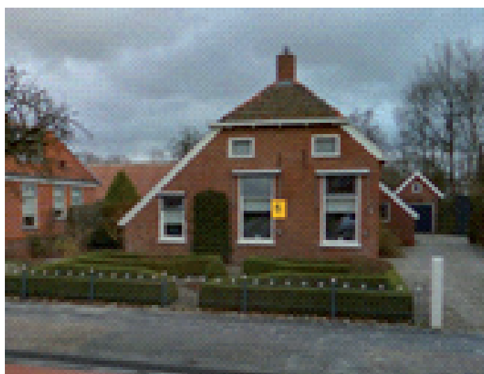
Groningerstraat 5 zeldzaam voorbeeld van keuterboerderij binnen de bebouwde kom van Roden en als onderdeel van ensemblebescherming Groningerweg 3 t/m 9 en Groningerweg 18/20
