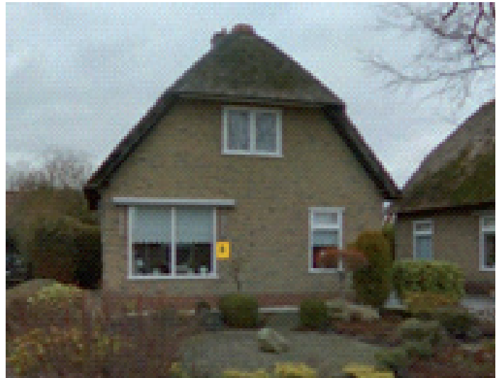
Zulthereschweg 8 zeldzaam voorbeeld van rietgedekte sociale woningbouw, Woonborg, 1950
