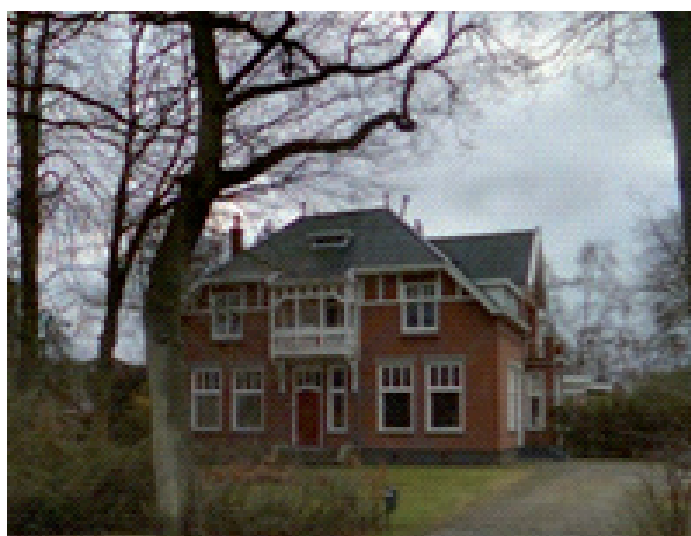
Leeksterweg 32-34 Villa, Hoofdvorm en detaillering, Overgangsstijl, met een combinatie van jugendstil- en chaletstijlvormen, ca 1910
