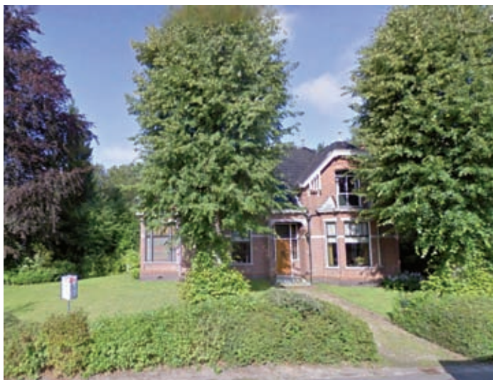
De Zulthe 8 (Rijksmonument) Boerderij uit 1857. Woonhuis is in 1909 bijgebouwd in Art Nouveau stijl. Ook de stookhut naast de boerderij behoort tot het monument.
