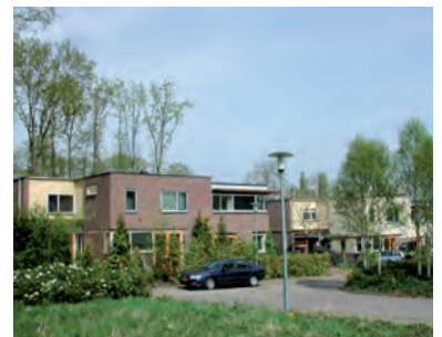
Geschakelde woningen bestaande uit samengestelde bakstenen blokken
