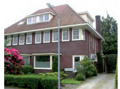
Horizontale geleiding komt tot uitdrukking in de vensterreeks onder de kap
