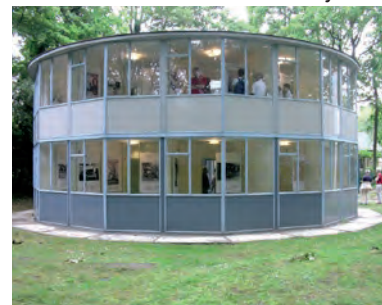
Achtkantig dienstbodehuis met ranke stalen kozijnen
