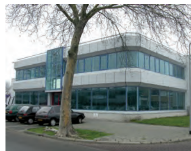
Kantoorblokken met horizontale gevelgeleding
