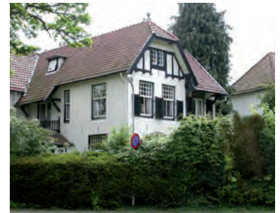
Gevels zijn voorzien van stijl- en regelwerk
