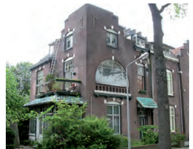
Bakstenengevels met siermetselwerkverbanden
