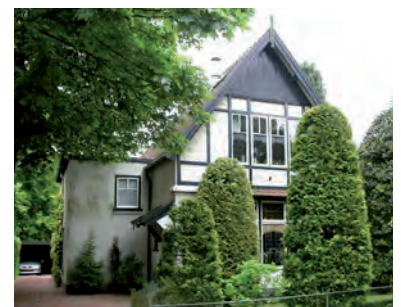
Gevels zijn in lichte tint gepleisterd
