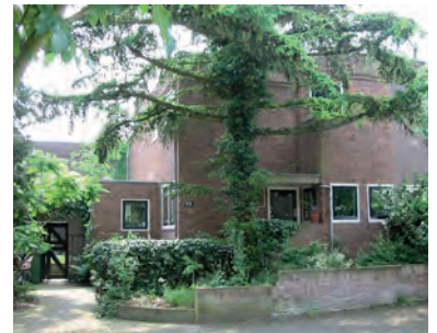
Gevels hebben een fijne baksteendetailering
