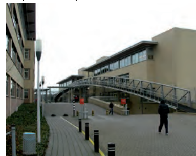
Brugconstructie bij het Nike-complex
