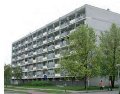
Herhaling in de gevel bij hoogbouw
