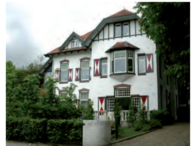
De voorgevellijn van het gebouw verspringt
