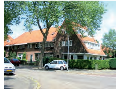
Gevels hebben horizontale geleding door aan elkaar gelijkende ramen
