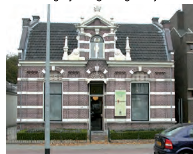
Gebouwen hebben eenvoudige hoofdvorm en zorgvuldige detaillering
