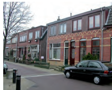
Fijne detaillering in het metselwerk
