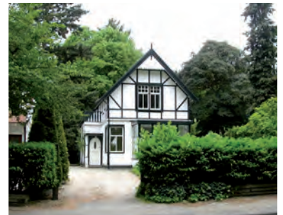
De detaillering van elementen als lijsten, balustrades en serres is decoratief
