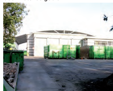
GAD overlaadstation met een eenvoudige hoofdvorm
