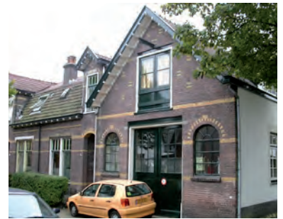
Kleinschalige arbeiderswoningen met een zorgvuldige detaillering
