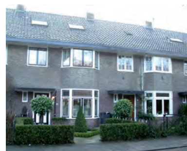
Ramen direct onder de dakrand
