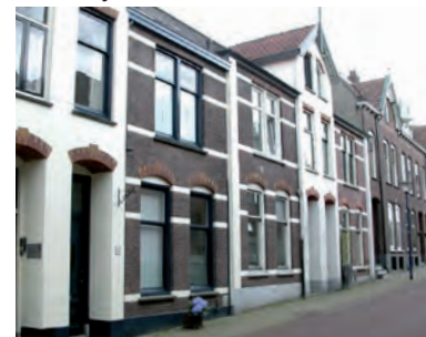
Geringe afstand tussen de hoofdmassa's
