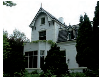
Gepleisterde gevels met decoratieve lijsten en gootklossen
