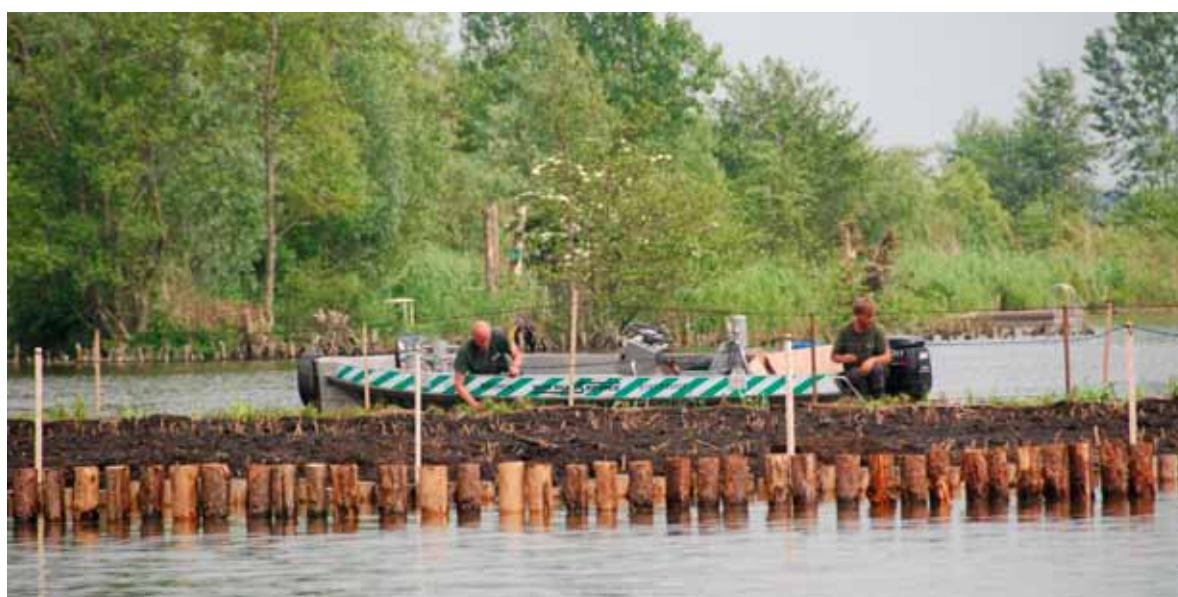
Herstel eilandstructuren Reeuwijkse Plassen, foto H. Bor.
