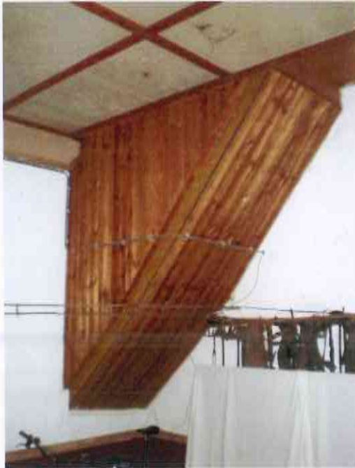
ONDERZIJDE TRAP NAAR ZOLDER
