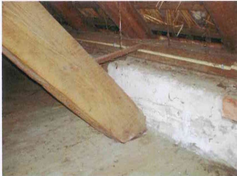
DETAIL MUURPLAAT / SPANT / DAK
