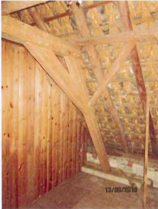
SPANT NAAST TRAPOPGANG
