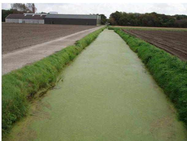
Figuur 2.3: Locatie bestaande hoofdwatgang verbreden en verdiepen incl. (zware) schotten beschoeiing langs het betonnenpad.
