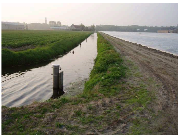
Figuur 2.1: Bestaande hoofdwatgang verbreden en verdiepen incl. schotten beschoeiing.
