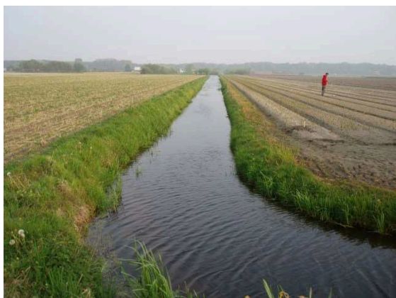
Figuur 2.5: Verbreden en verdiepen bestaande hoofdwatgang, incl. schotten beschoeiing.
