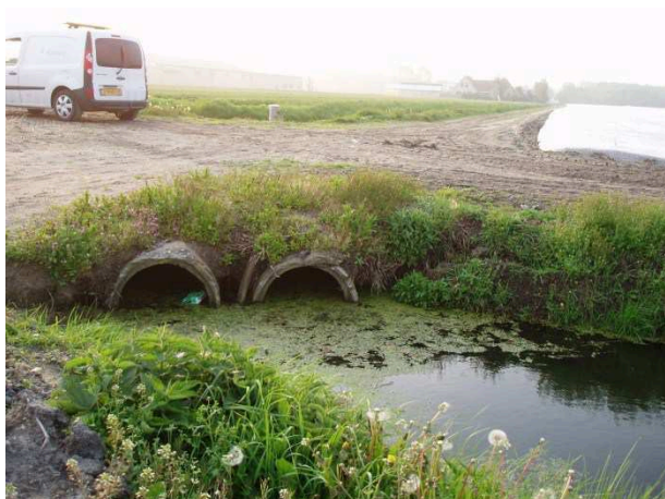
Figuur 2.4: Bestaande landbouwdam met te hoog gelegen duikers, vervangen door staal 1.200 mm.
