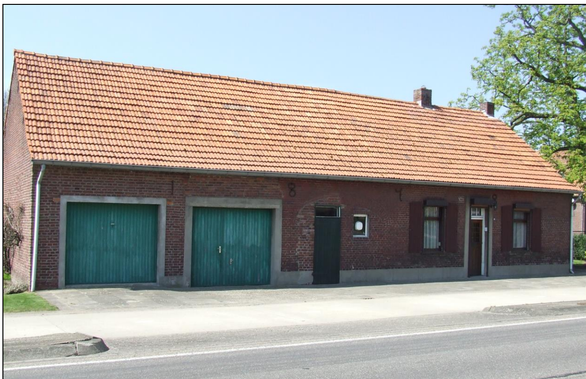
Figuur 16: De huidige boerderij Nijken 16 die volgens de muurankers uit 1878 dateert.
