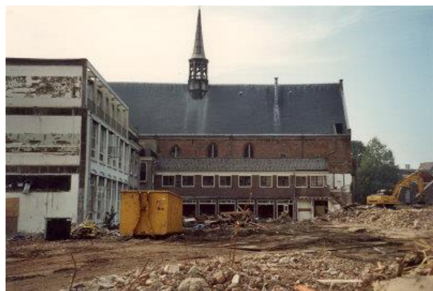
Voorbereiding sanering Janskliniek
