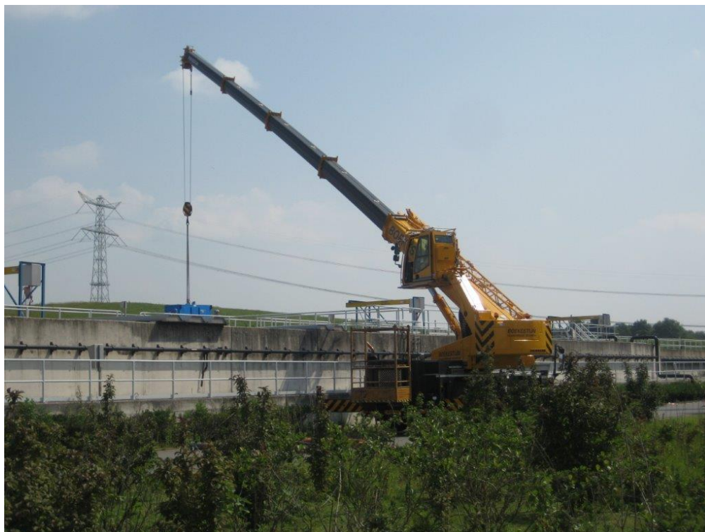
Betonreparatie beluchting Rwzi Dordrecht
