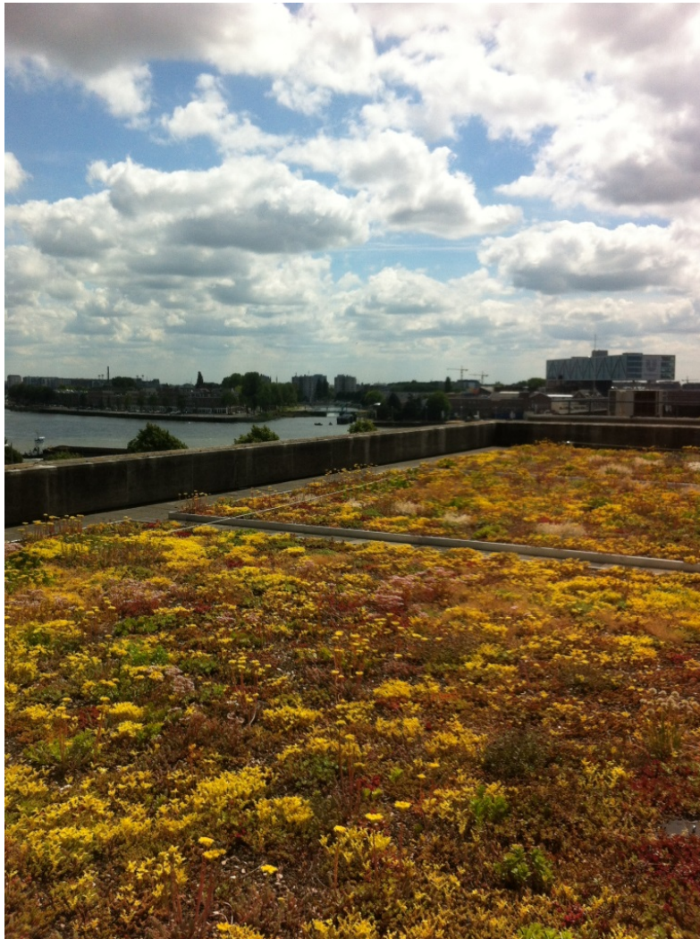
Foto: 'Groen' dak, Maasboulevard Rotterdam
