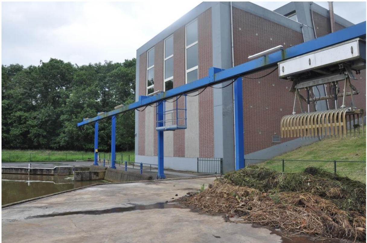
Foto: de achterzijde van gemaal Abraham Kroes
