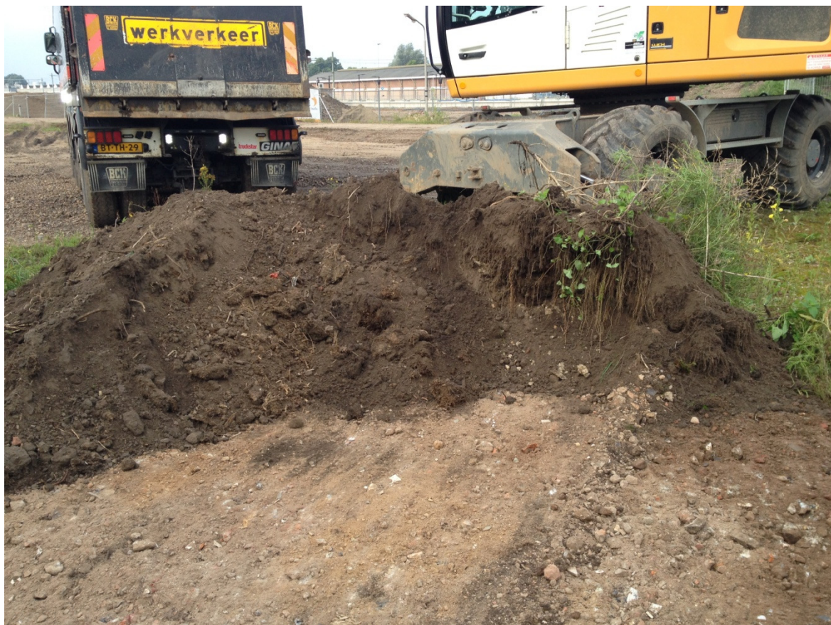
Afvoer depot asbesthoudende grond A
