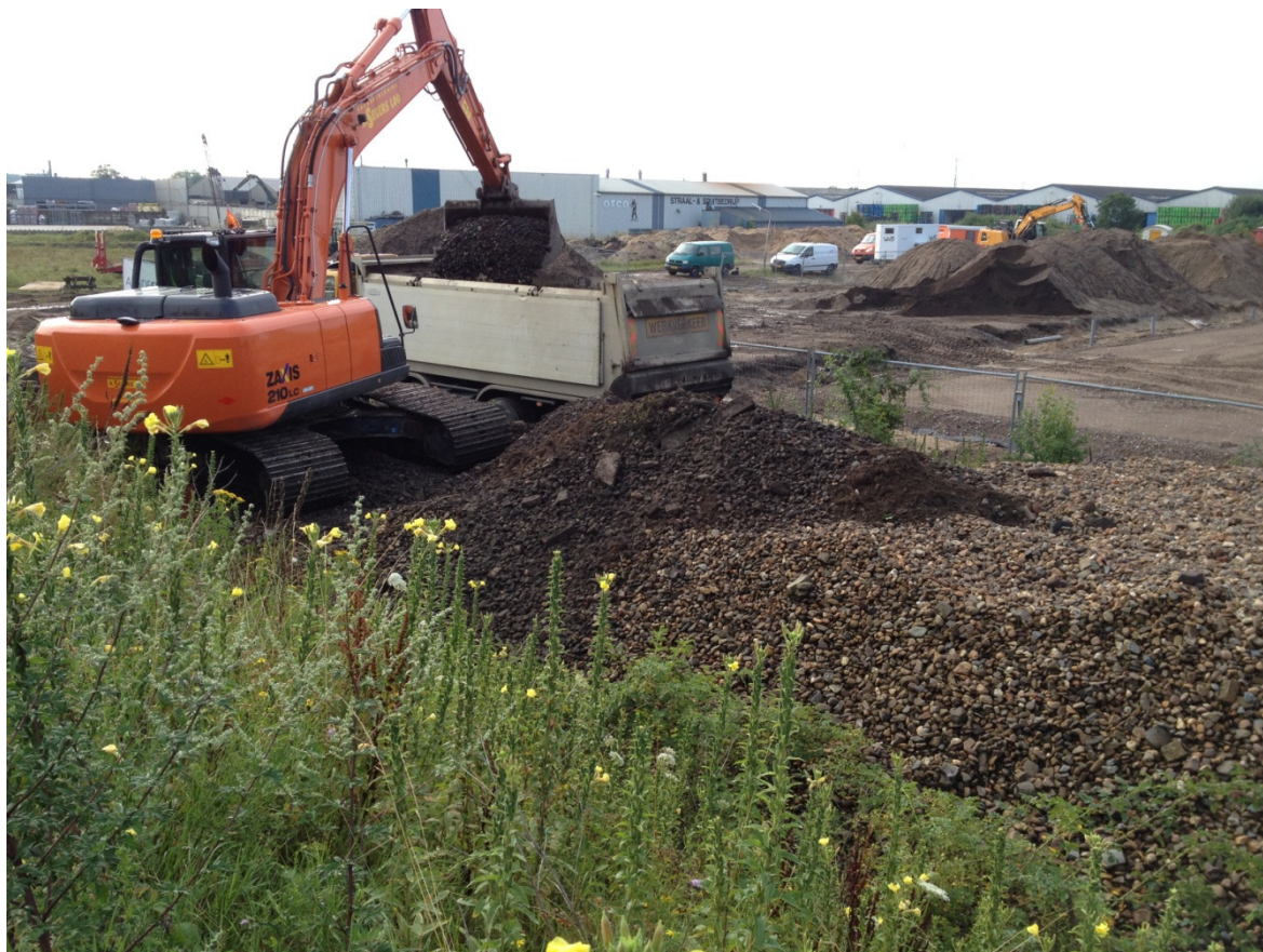
Opladen depot E
