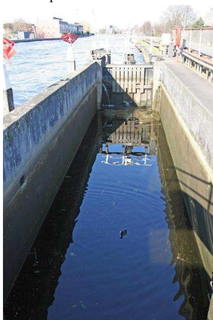
Foto 3.6: inlaat en sluis Gouwepolder
