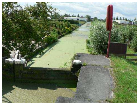
Foto 3.5: sluis Otwatering Laag Boskoop
