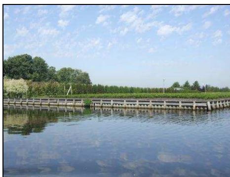
Foto 3.12 & 3.13: harde beschoeiingen bij de boomteeltpercelen
