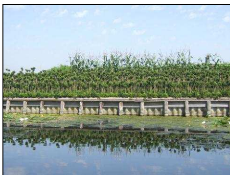
Foto 3.12 & 3.13: harde beschoeiingen bij de boomteeltpercelen
