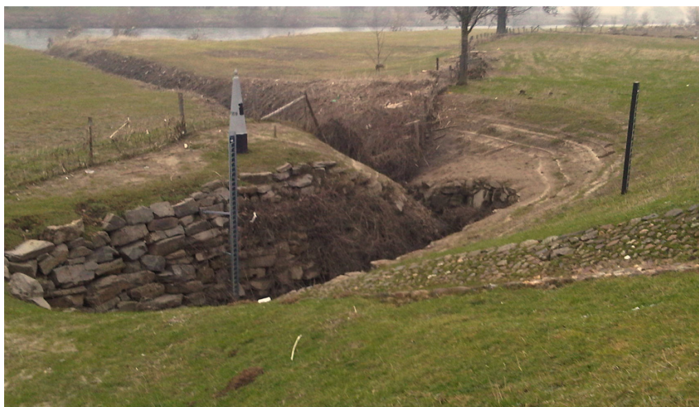
Afbeelding 8.2. Spoelgoot buitentalud en sloot met stenen muurtje
