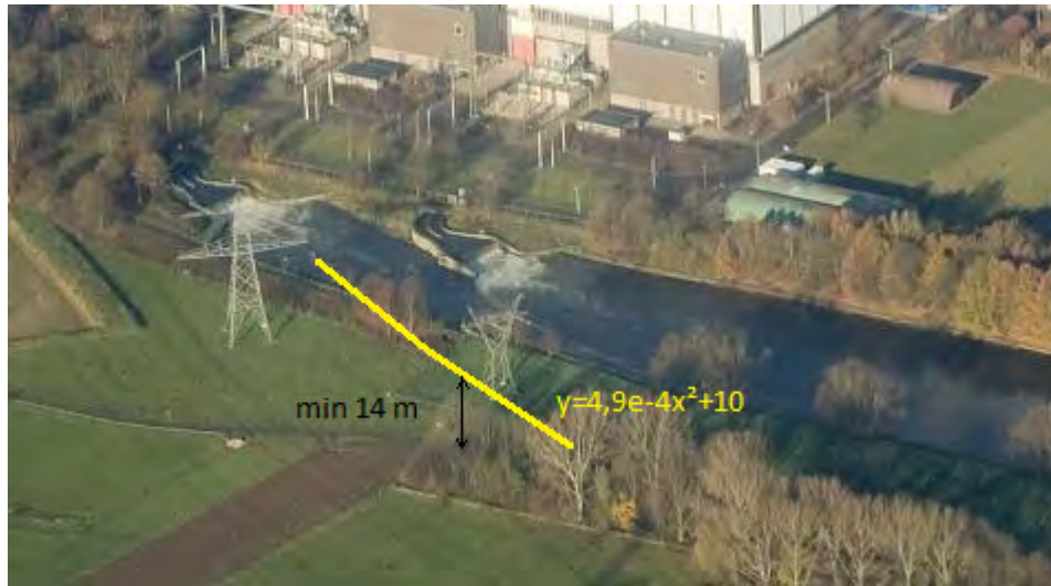
Afbeelding 8.8. Hoogspanningsleidingen Essent en TenneT op dijkvak 50.660.1
