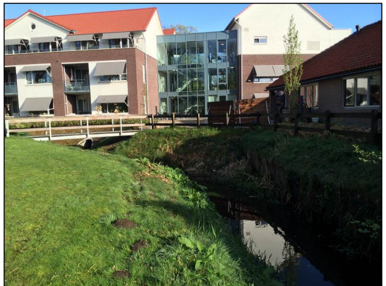
Afbeelding 5: Weerselerbeek gaat via een lange duiker onder bebouwing door
