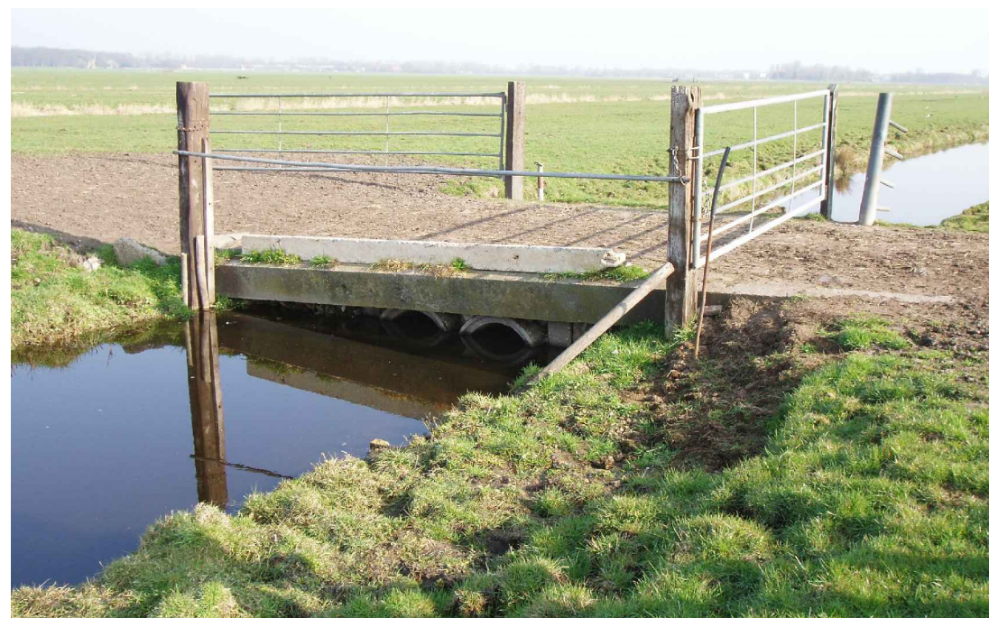
foto bestaande duiker zuidwestzijde
