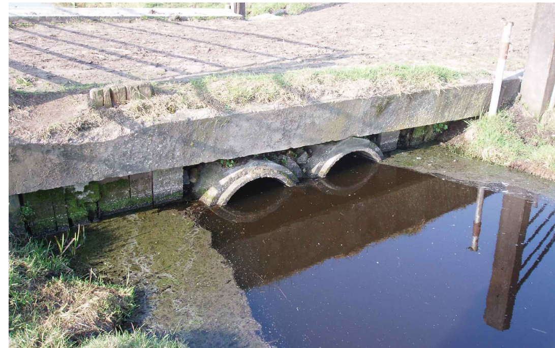
foto bestaande duiker noordoostzijde
