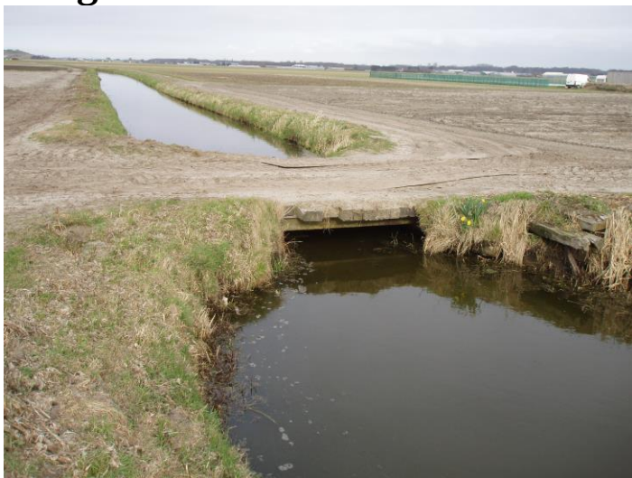
Foto 1. Overzicht van bestaande hoofdwatgang met verzakte brug en forse vernauwing in hoofdwatgang. (breed ca. 1,70 en ca. 30 cm diep)
