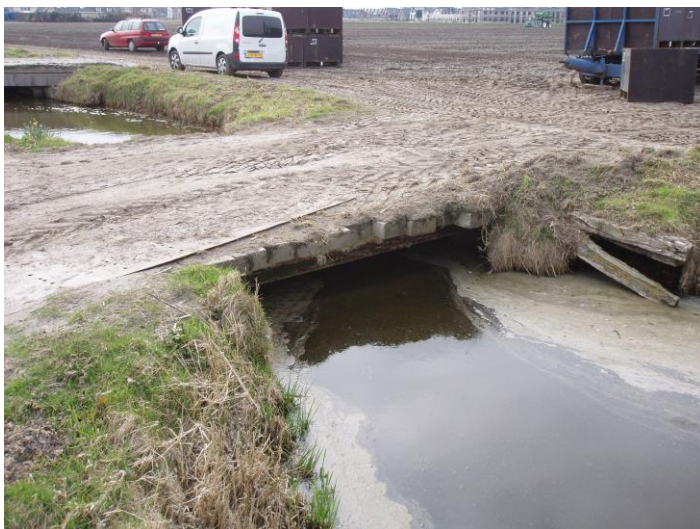
Foto 2. Overzicht van bestaande hoofdwatgang met verzakte brug en forse vernauwing in hoofdwatgang. (breed ca. 1,70 en ca. 30 cm diep)
