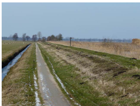
Figuur 10.1) Bestaande situatie traject E bij fietspad
