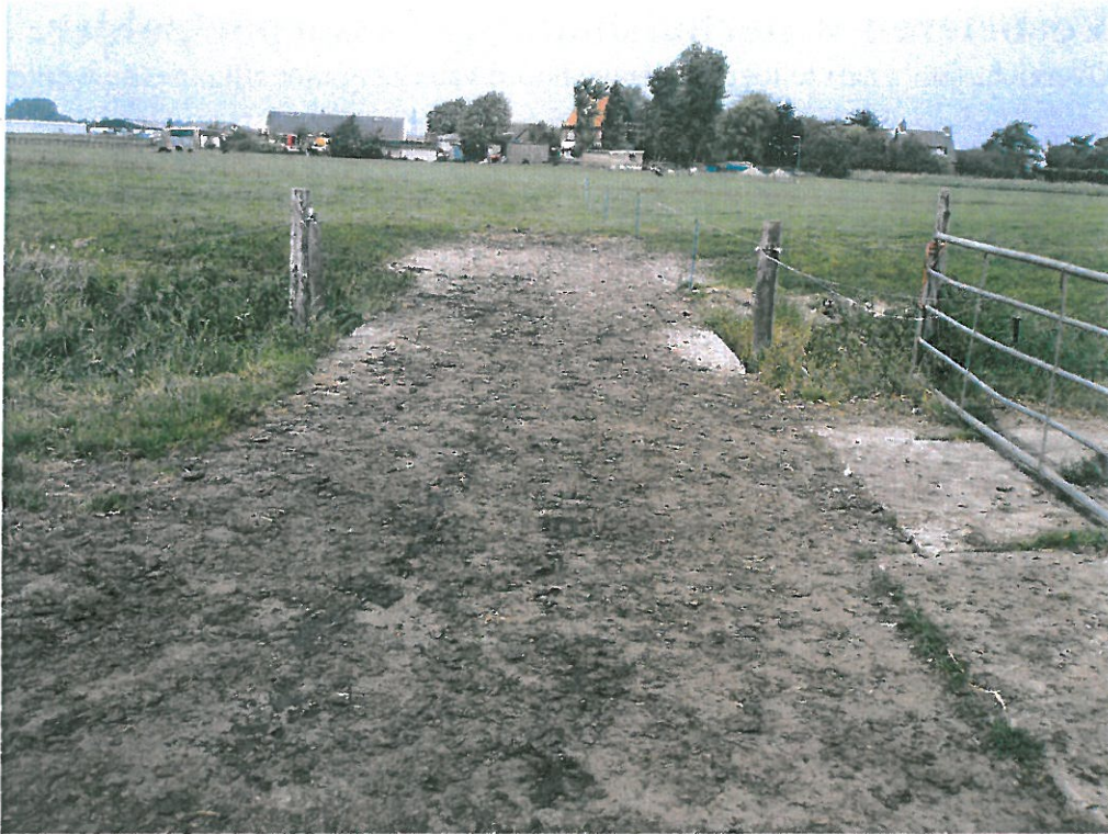
Foto 3. Overzicht van bestaande hoofdwatgang met betonnen landbouwbrug. Maatregel: Verplaatsen betonnen landbouwbrug naar nieuw te graven hoofdwatgang (door Rijnland). Huidige hoofdwatgang dempen. Nieuwe hoofdwatgang met een breedte op de waterlijn van 4,0 meter t.o.v. winterpeil. Graven nieuwe hoofdwatgang door Rijnland, doch transport en verwerken grond door ingelanden. Ruimte beslag zal verrekend worden d.m.v. een waterbalans. Eigendom blijft bij ingelanden
