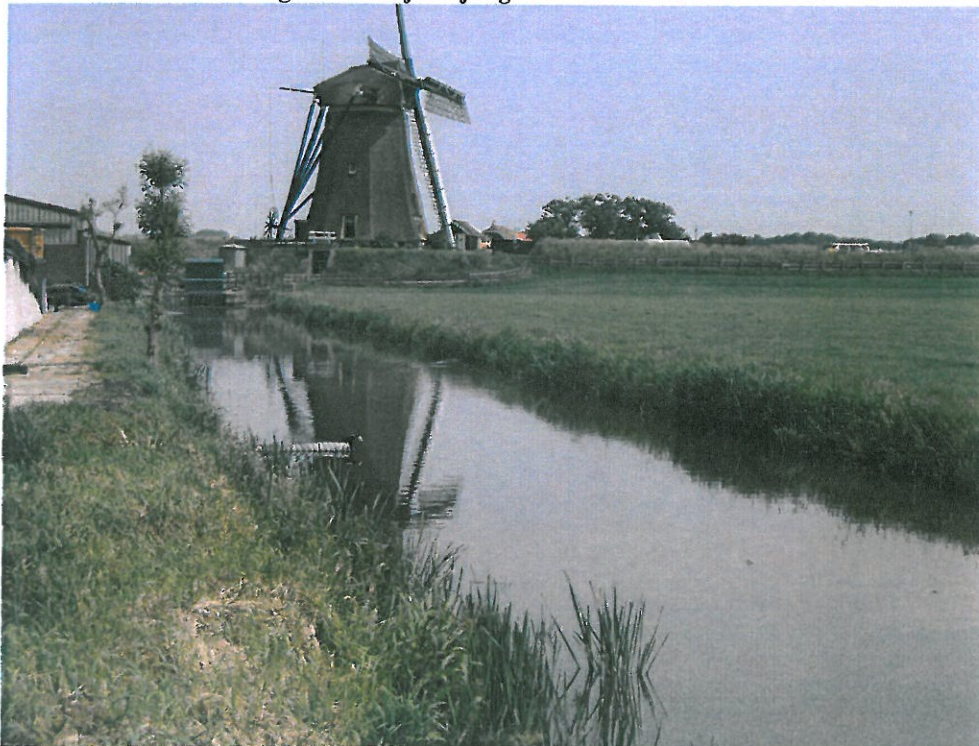
Foto 10. Overzicht van huidige hoofdwatgang met te verwijderen duiker onder het boerenerf. Maatregel: Verwijderen van duiker in het erf, vanwege het graven van een nieuwe hoofdwatgang, zoals aangegeven in foto's 6 en 7. Duiker verwijderen door Rijnland en sleuf aanvullen met zand. Vrijkomende Spirosol duiker t.b.s. ingelanden. Zakelijk recht c.q. opname in de legger van deze duiker komt te vervallen. Ruimte beslag van de Bypass
