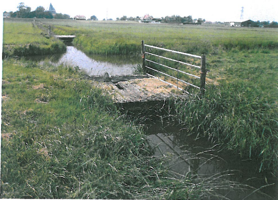
Foto 5. Overzicht van bestaande hoofdwatgang met houten landbouwbrug.
