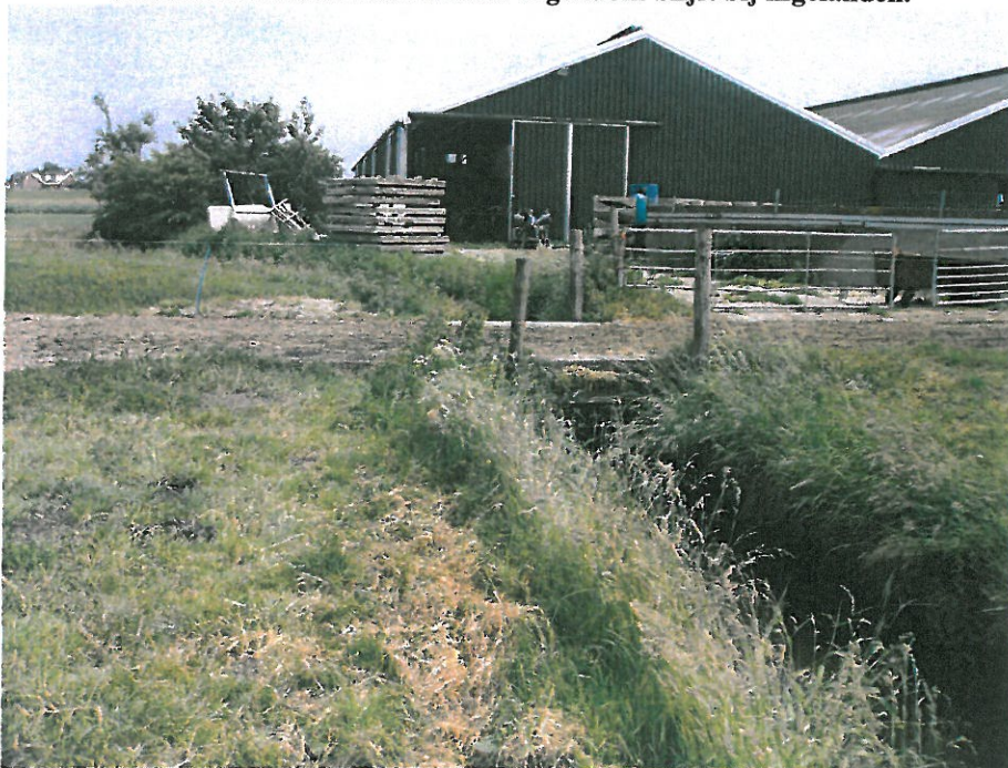
Foto 2. Overzicht van bestaande hoofdwatgang met betonnen landbouwbrug.
