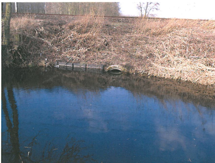
Foto 6. Overzicht bestaande betonnen duiker onder de spoorbaan door, welke de verbinding vormt met de boezem en het beheer en onderhoud verbeterd door het opheffen van de windmolen met te krappe en lange duiker onder de spoorbaan door (zie ook foto 2)
