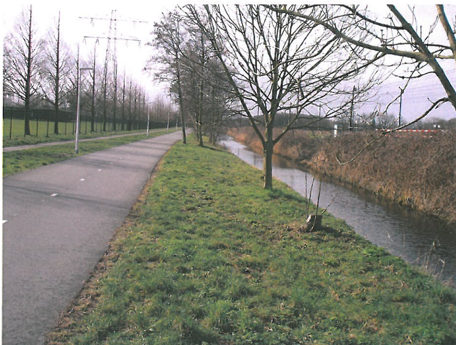
Foto 3. Overzicht van nieuw aangelegd fietspad met naast gelegen bermen en elzen/essen bomen. Zicht vanaf windmolen naar te vergraven dam.
