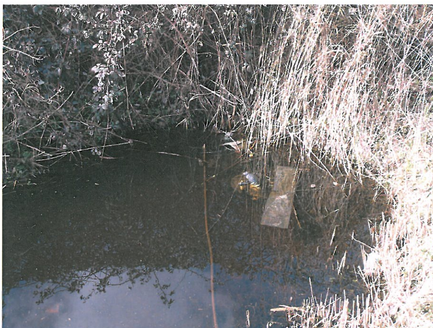
Foto 2. Overzicht van bestaande lange duiker onder de spoordijk door en slechte afwatering vanaf bestaande windmolen met weinig windaanbod t.g.v. bomen en bebouwing, peil op 1.10 – nap.
