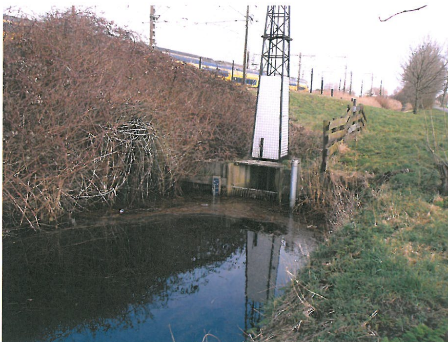
Foto 1. Overzicht van bestaande windmolen met weinig windaanbod t.g.v. bomen en bebouwing, peil op 1.10 – nap en afvoer via krappe lange duiker (ca. 100 meter) zie ook foto 2.
