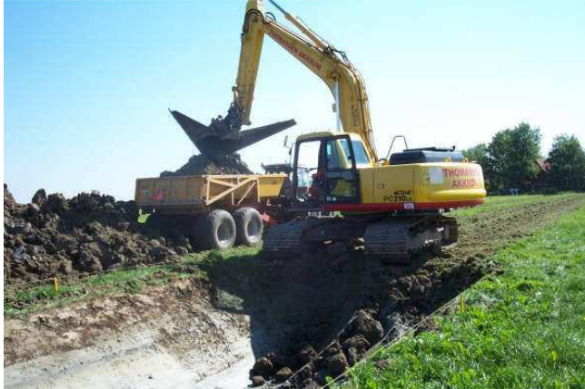
Foto 2: voorbeeld van het graven van een sloot
