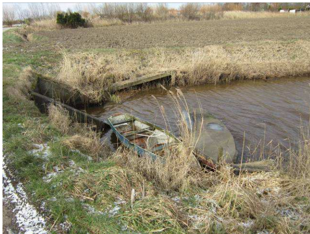
Fotonummer: 2 Omschrijving: Locatie 1: Duiker onder Drenkhoos
