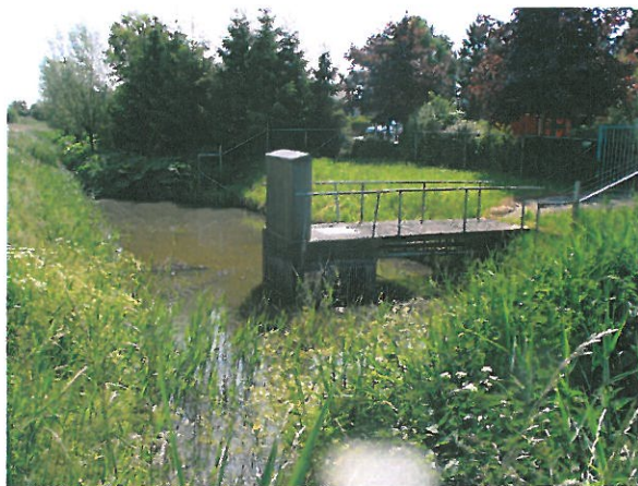
Figuur 1B Foto poldergemaal IJpolder, huidige situatie.
